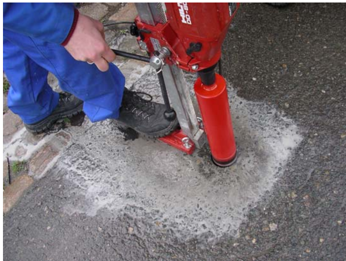
Figur 1. Boring av asfaltkjerne.
