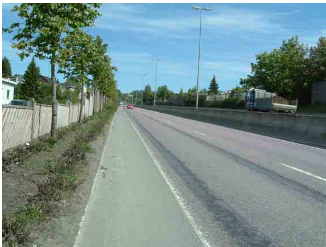
Figur 34. Bilde fra Omkjøringsveien ved prøvelokaliteten (Motor-Trade) som viser slitasje i slitesporet.
