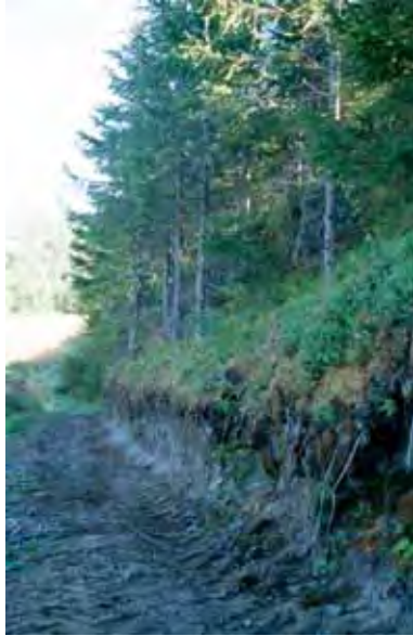
Figur 13. Skjæring langs traktorvei ved foten av RV 851.
