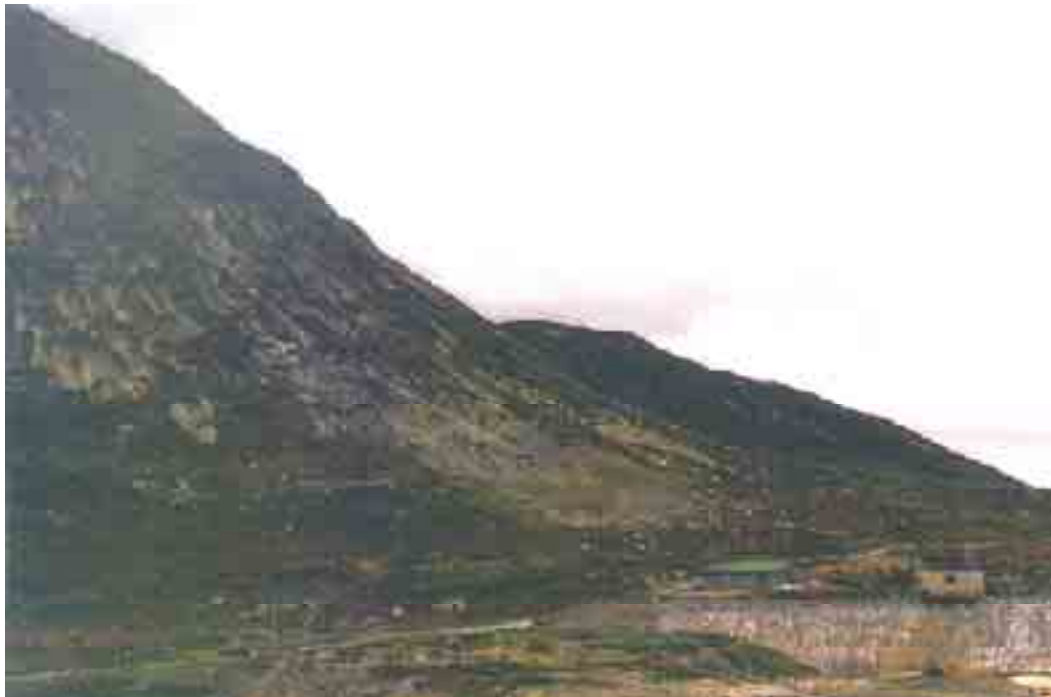
Figur 7: Bildet viser murt dam ved sydenden av Mår. Steinen er tatt fra foten av fjellet midt på bildet.
