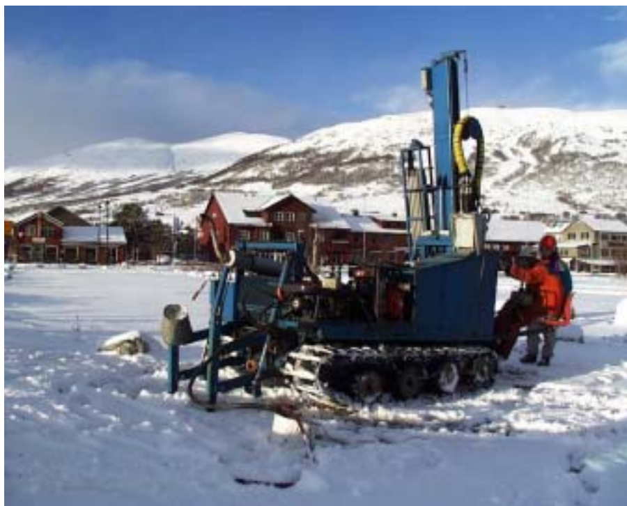
Figur 5. Fra undersøkelsesboringer i Oppdal november-01.
