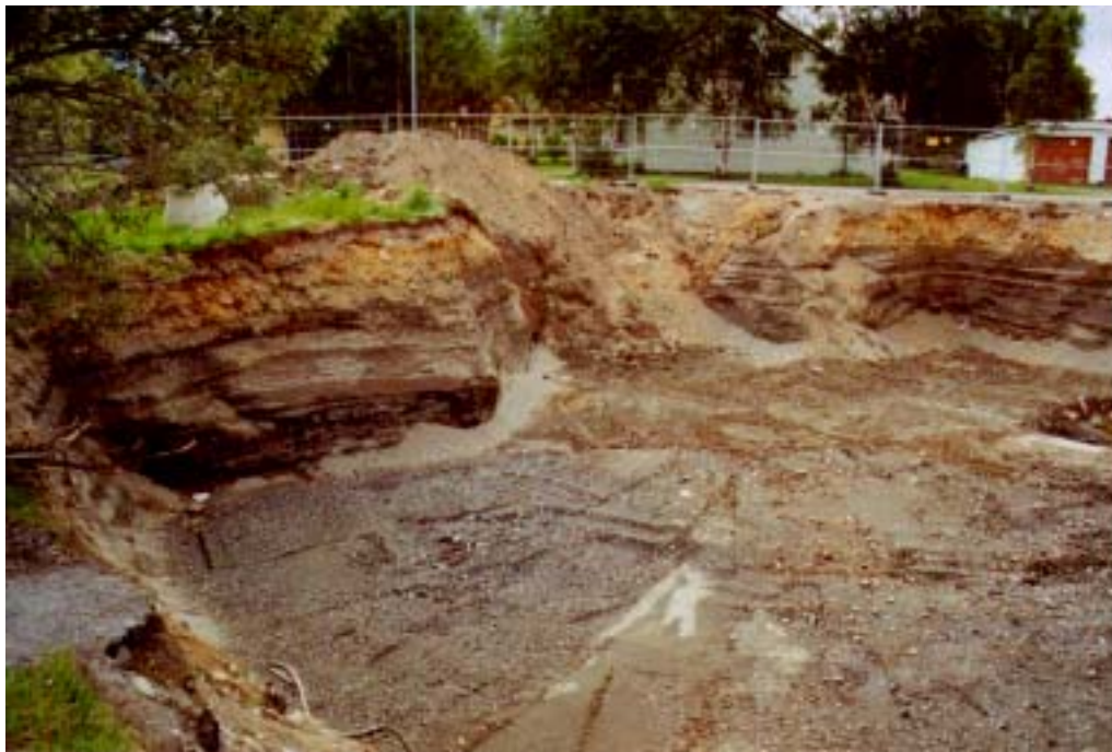
Figur 4. Bilde fra ei byggegrop ved georadarprofil 5. Informasjon fra boringene og observasjoner fra byggegropa er brukt som fasit for tolkningene av georadarprofilene.
