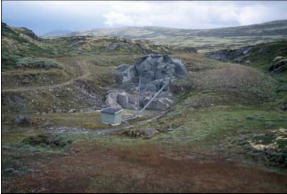
Figur 11 Bubakkbruddet med steinkran og maskinhus, sett mot syd.
