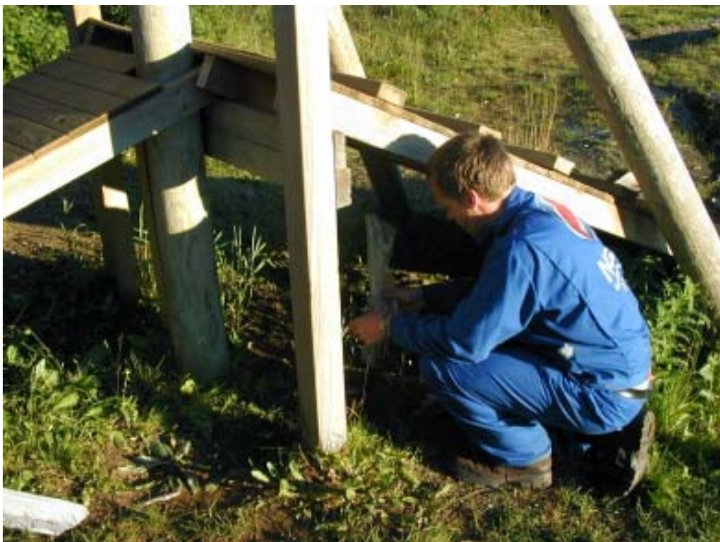
Figur 4. Trykkimpregnert tre må beholdes slik det er, og ikke sages eller hugges i. Sagflis og spon fra trevirke impregnert med arsen, kobber og krom vil være svært giftig.
