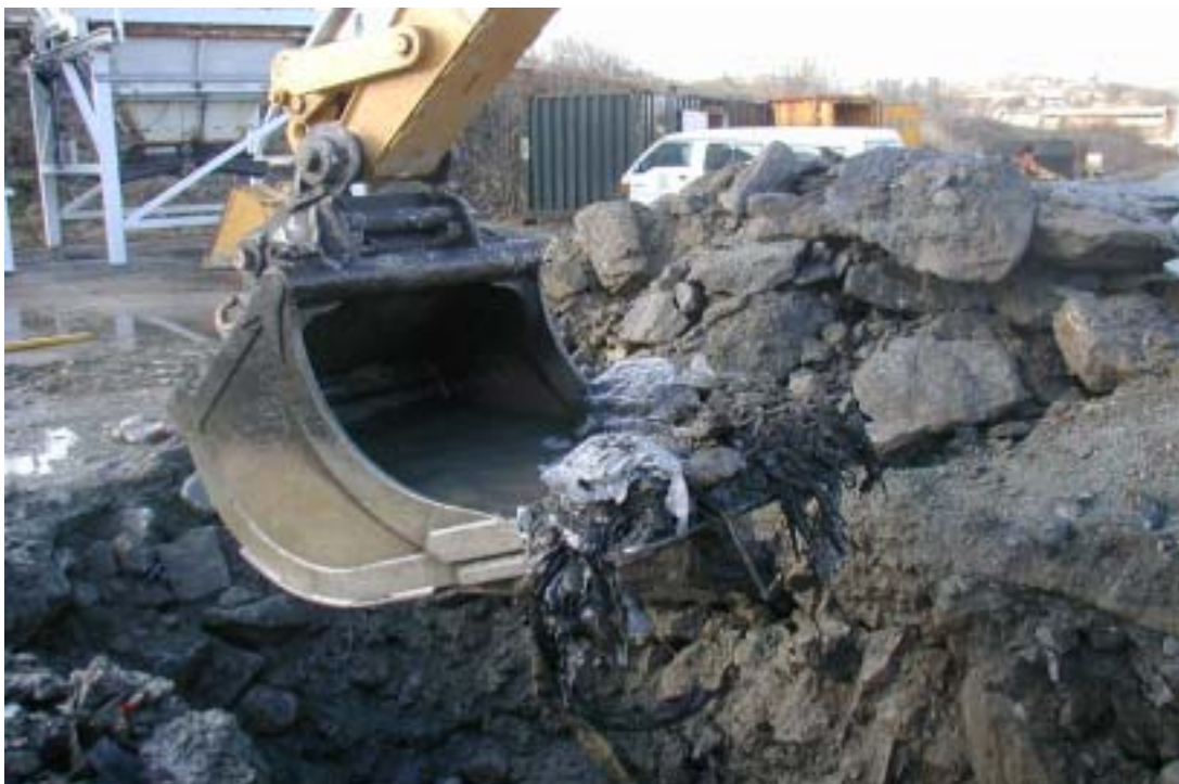
Figur 4 Avfallsmasser fra den nedlagte kommunale fyllplassen. Deponiet strekker seg et godt stykke inn på det undersøkte området.
