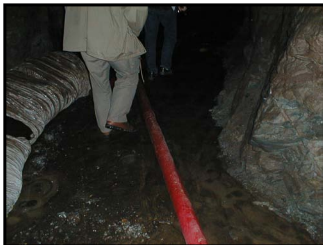
Figur 2 Brukt blåsesand i adkomsttunnelen til trykkrørene i Løkaunet kraftverk. Anslagsvis er det 20 tonn blåsesand i tunnelen. Sanden er av typen kull-slagg.
