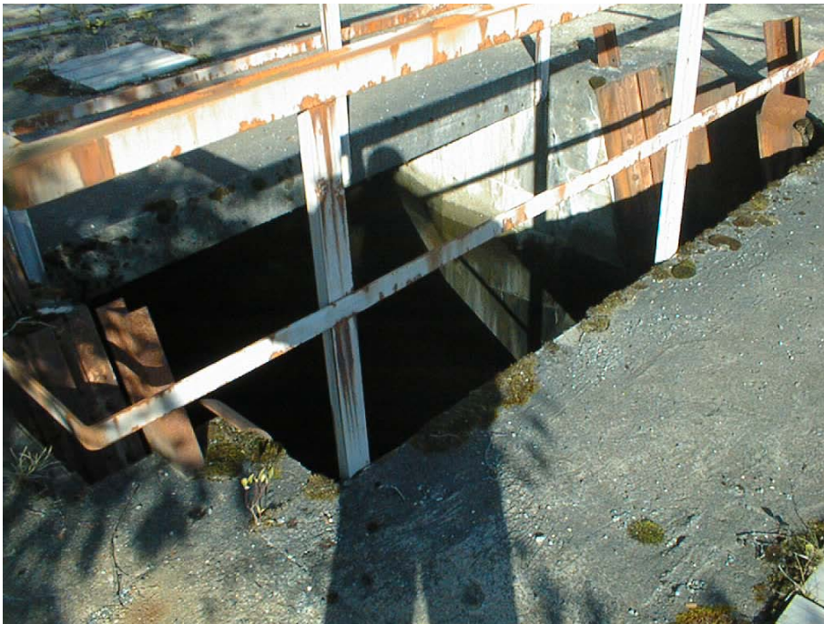
Figur 13 Sjakt ved Fjæremsfossen kraftverk.
