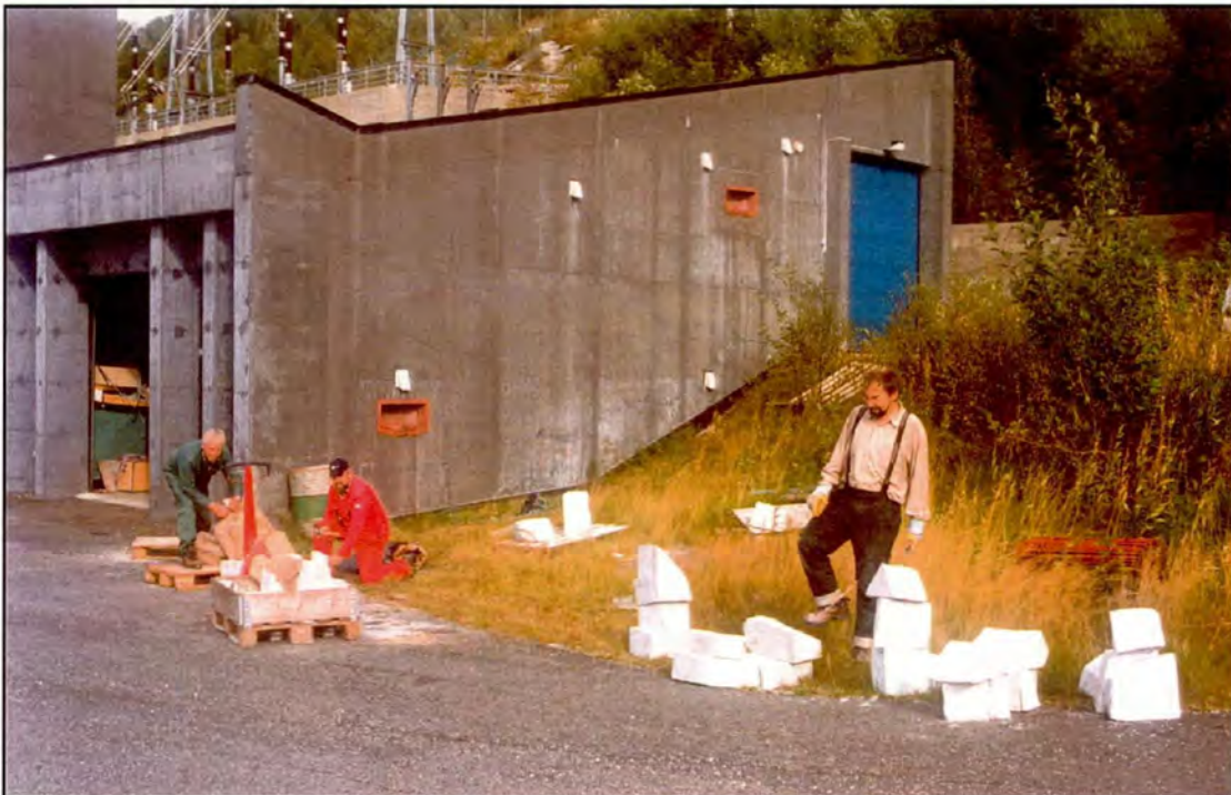
Figur 19. Klargjøring av blokk ved Kobbelv Kraftstasjon for forsendelse til oppredningsforsøk hos SINTEF.
