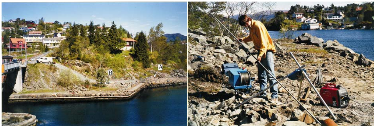
Figur 3. Boreplass A og B nede ved sjøen (venstre), staking av sonde ned i hull (A1). (Foto, Lars Larsen).
