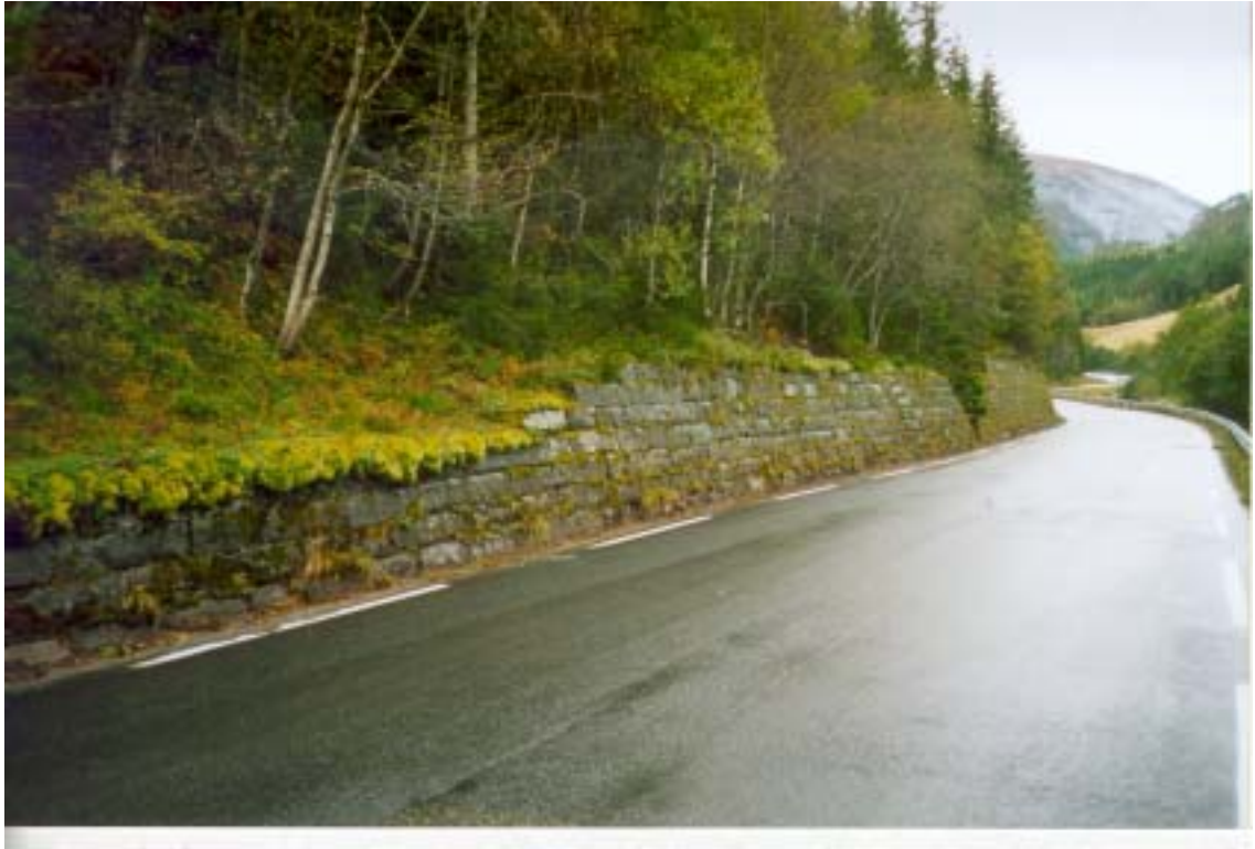
Figur 11 Forstøtningsmurer av tykkbenket Snilldal-skifer
