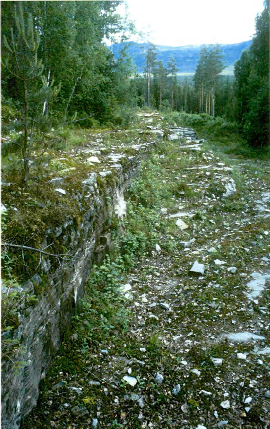
Figur 18: Oversiktsbilde av Haukeli skiferforekomst, sett mot nord. Grunneieren har her avdekket forekomsten i 70 meters lengde (tilsvarer figur 19).
