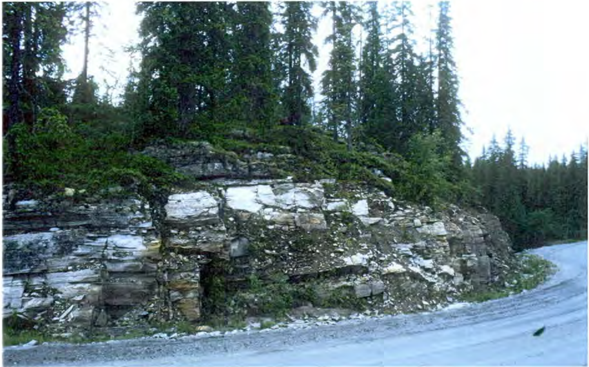
Figur 16: Veiskjæring av kvartsittskifer ved Holmevatnet like nedenfor Fagerfjell. Legg merke til den vertikale oppsprekningen. Det ligger også to hytter på toppen av denne kollen.
