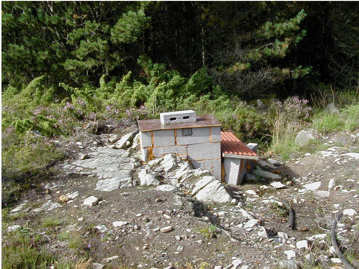
Figur 4.1 Bildet viser brønnhuset rundt BH2 fotografert 29.08.2001. Torva er fjernet og fjellet er rengjort før huset er bygd opp.
