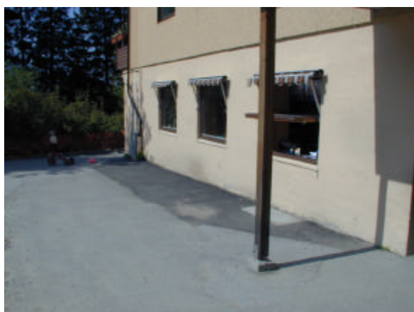
Figur 2.2.c Fotografier fra Fløen barnehage etter at tiltak ble iverksatt. Den forurensede jorden ble fjernet og erstattet med ren jord. Inntil husveggen ble det lagt asfalt.
