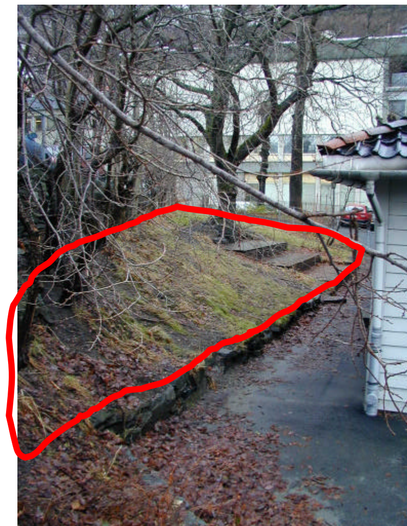
Figur 2.4.b Fagertun barnehage. I det avmerkede området er jorden forurenset med bly og den anbefales gravd bort og erstattet med ren sand.
