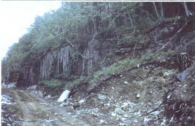
Figur 8: Oversiktsbilde av skrenten ovenfor nyveien vest for Toeneiet mellom 100 og 140 m (se figur 4). Det er en velutviklet skifrihet i det meste av dette partiet.
