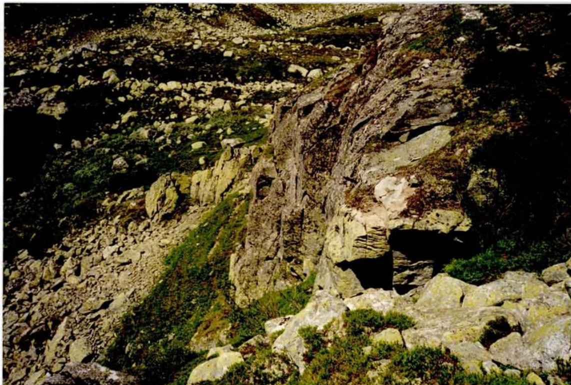
Fig.14. Sprekker i nord-nordvestlig retning med løsblokker langs stupet på østsiden av Urdbøuri. Øverste del av Urdbøuri til venstre.
