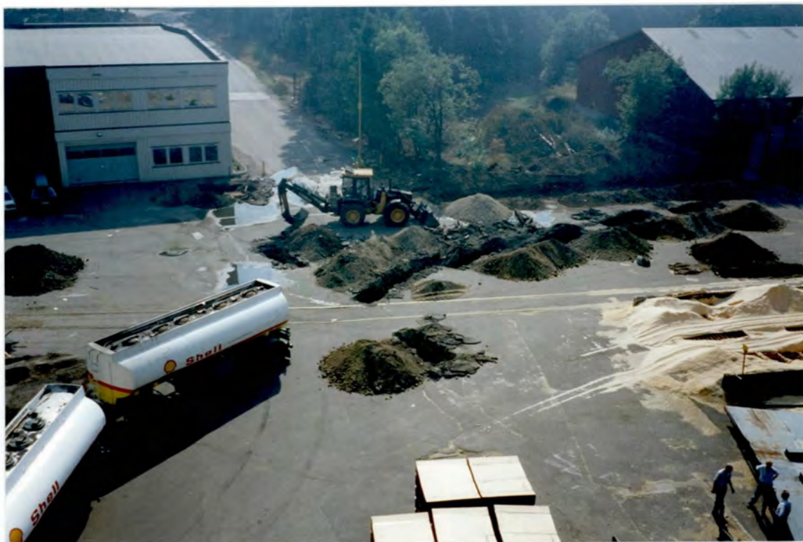
Fotobilag 2: Oversikt over gravearbeidet
