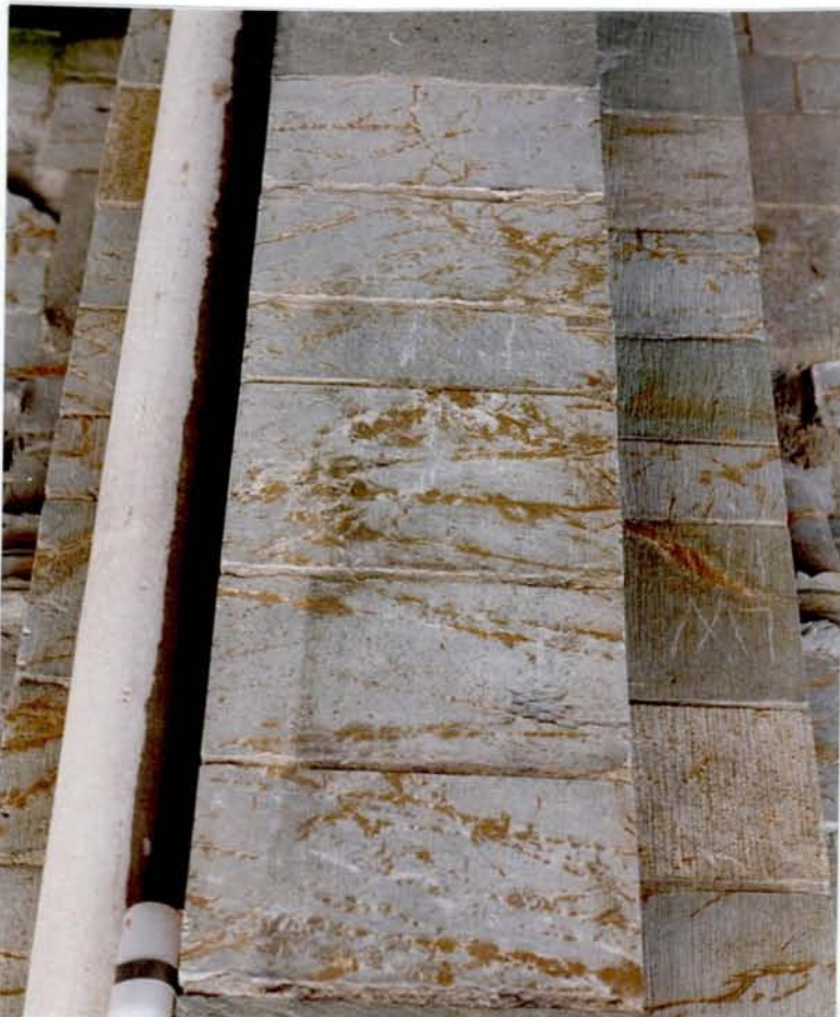
Figur 11 Klorittskifer fra Øye brukt i mur i Nidarosdomen (homogen, grønnlig på bildet) i kombinasjon med karbonatrik kleberstein fra enten Bakkaune eller Klungen/Huseby.
