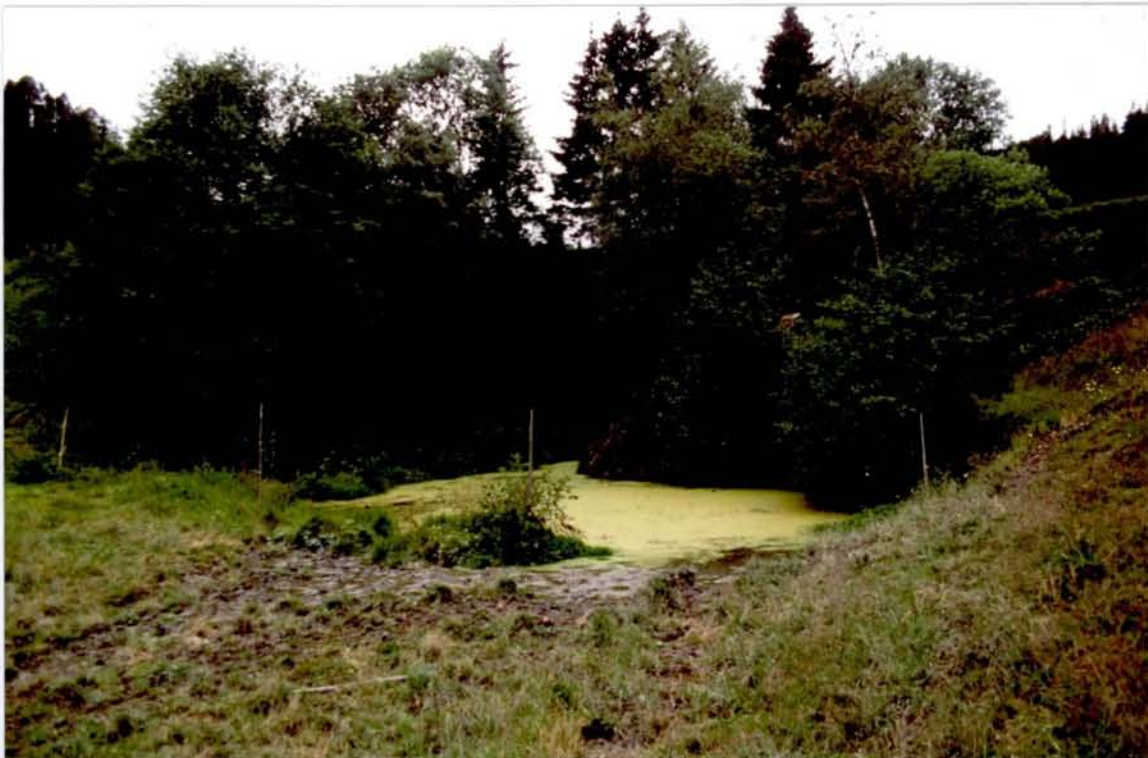
Figur 7 Brudd i Klungen (K1) sett fra øst. Laveste del av bruddet er vannfylt.
