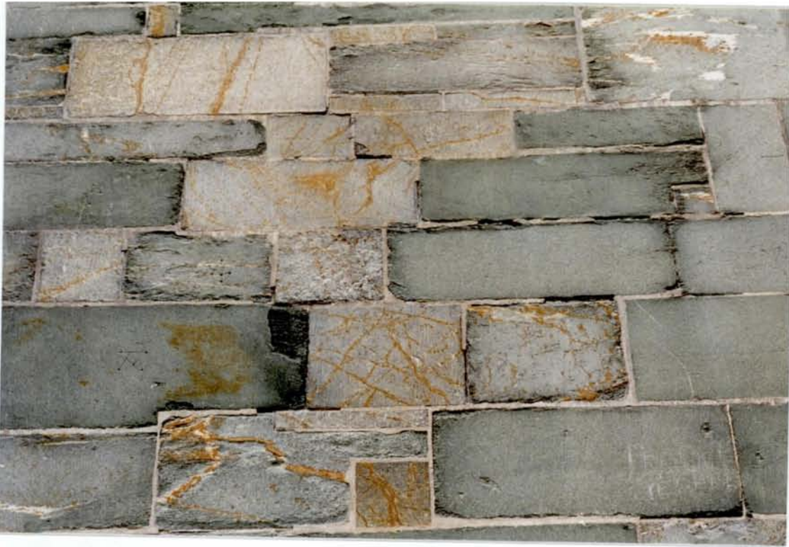
Figur 11 Klorittskifer fra Øye brukt i mur i Nidarosdomen (homogen, grønnlig på bildet) i kombinasjon med karbonatrik kleberstein fra enten Bakkaune eller Klungen/Huseby.
