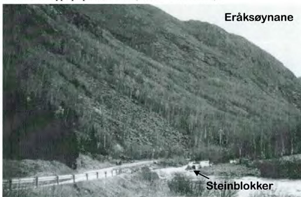
Figur 23. Dalside dominert av steinsprang ved Eråksøyne.
