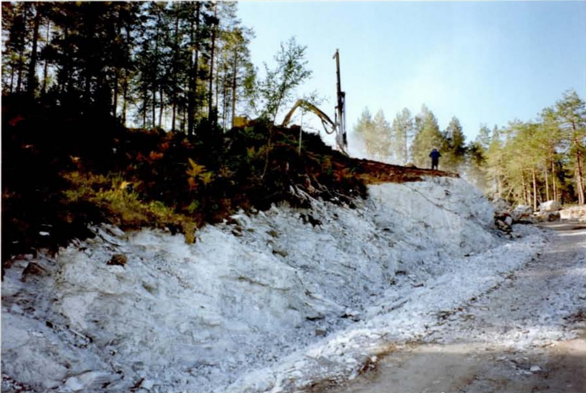
Figur 4. Skjæring ved ny skogsveg opp for Nybø
