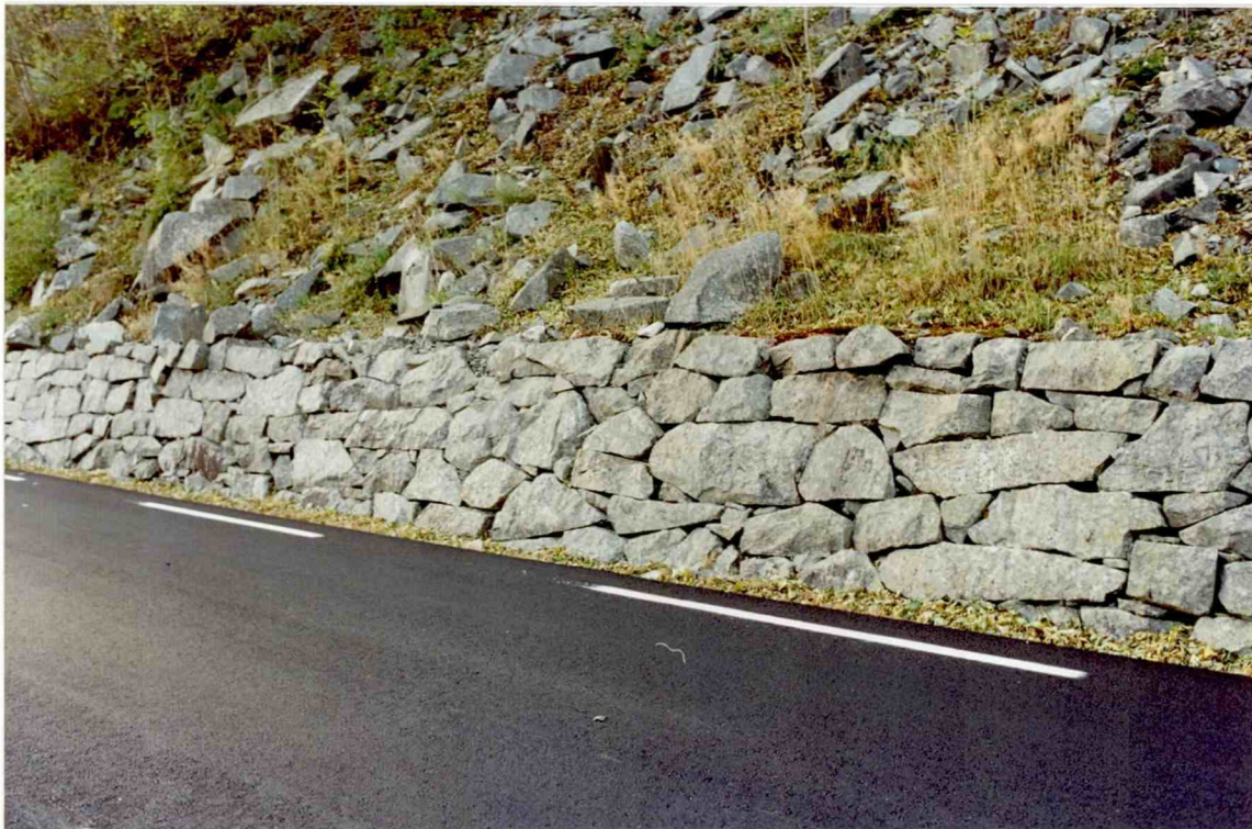
Figur 7. Granittmur ved fylkesvegen vest for Åkra. Relativt ujevne sideflater og sparsomt med rettvinklede hjørner indikerer utilfredstillende kløvegenskaper
