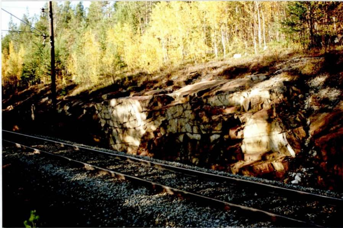
Figur 3. Jernbaneskjæring i trondhemitt nord for Dombås (nær lok. 1). Tett oppsprekning dominerer.
