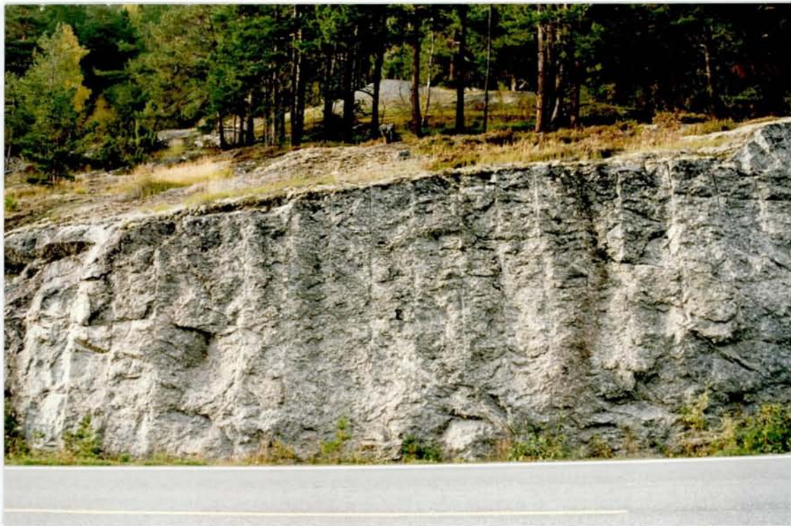
Figur 11. Veiskjæring i relativt massiv øyegneis ved riksvegen i Gråura (lok. 10) øverst Sunndalen. Fine sva bakenfor som kan være gunstige for blokkuttak
