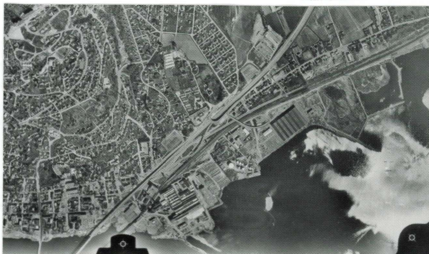
Figur 1 b Flyfoto fra 1977 (Fjellanger Widerøe A/S). Den gamle fyllinga på Lierstrand er nå fylt over, og det er anlagt industriområde. Store utfyllinger fra Brakerøya og langs Lierstranda.
