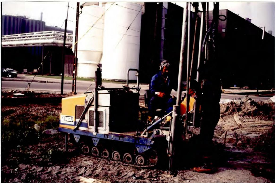
Figur 2. Prøvetaking av løsmasser ved kloralkalifabrikken.
