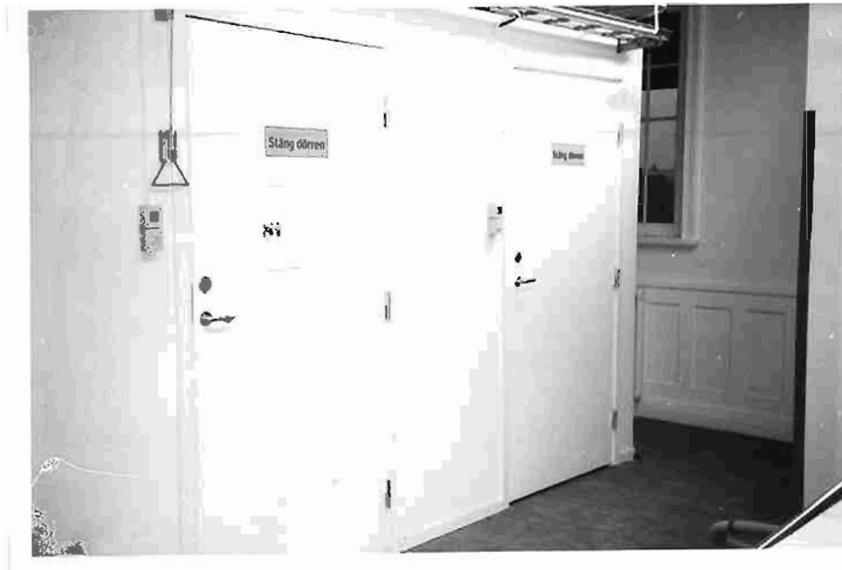
Foto nr. 1. Knuse- og sikteutstyr er plassert i små "kiosker" som ligger på rad og rekke.
