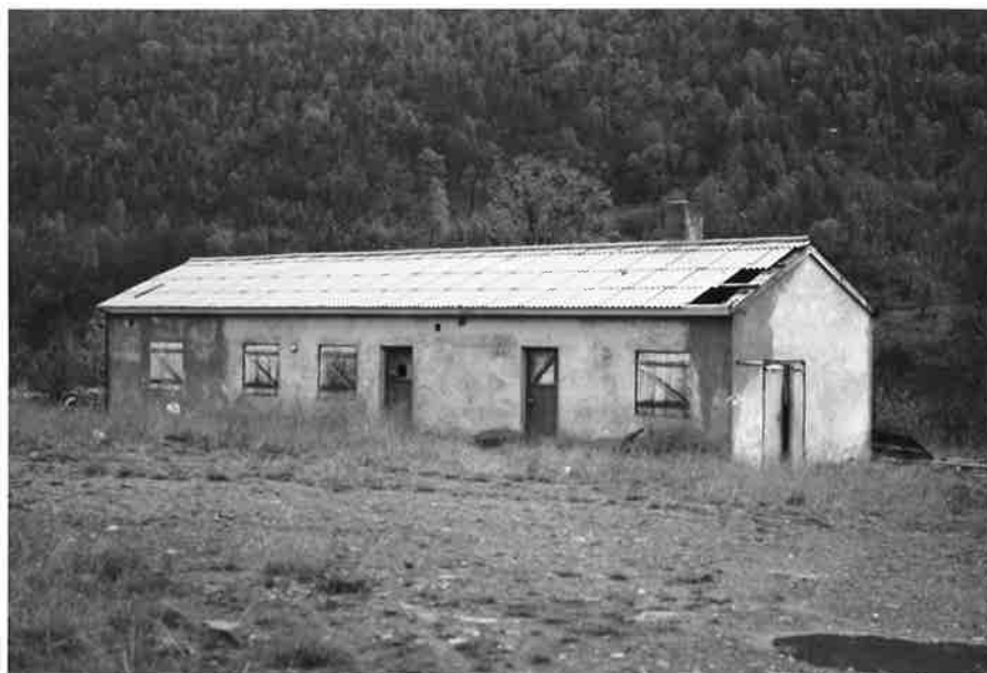
Foto nr. 36. Bad- og fyrhusbarakken i Vaddas. 1734 IV, 5.22.800 - 77.45.250
