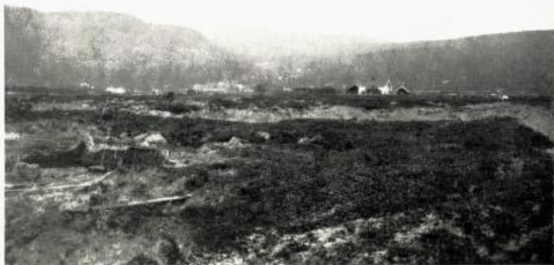
Fig. 5. Jevn indsynkning av lermassene ved Aaserud Teglværk (pr. Drammen).
