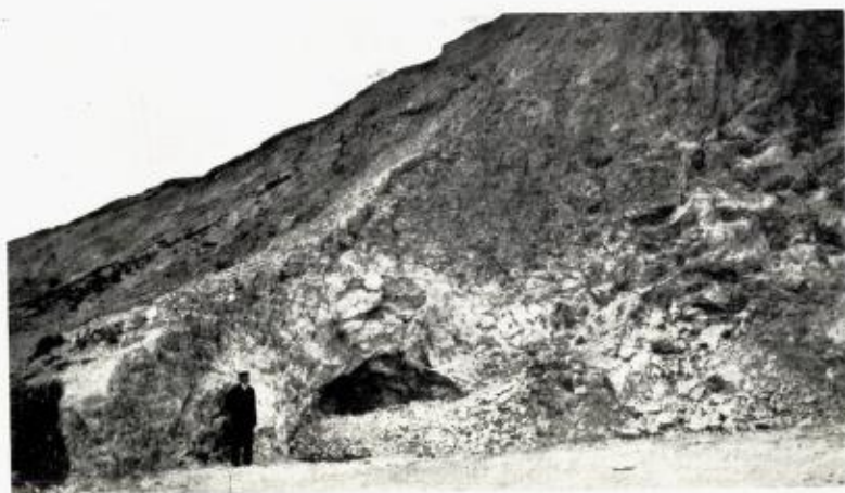
Fig. 8. Del av 28 m. høj lerskjæring ved Graverens Teglværk No. 3.
