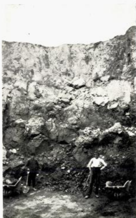
Fig. 3. Eksempel paa høi lerskjæring, gammeldags drift, (merk den lyse sekundærsonen øverst).
