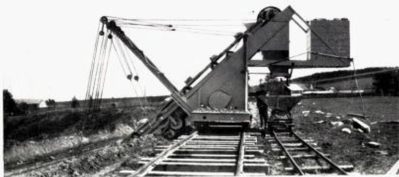
Fig. 7. Gravemaskine i Strindens Teglverks lertak (pr. Trondhjem).
