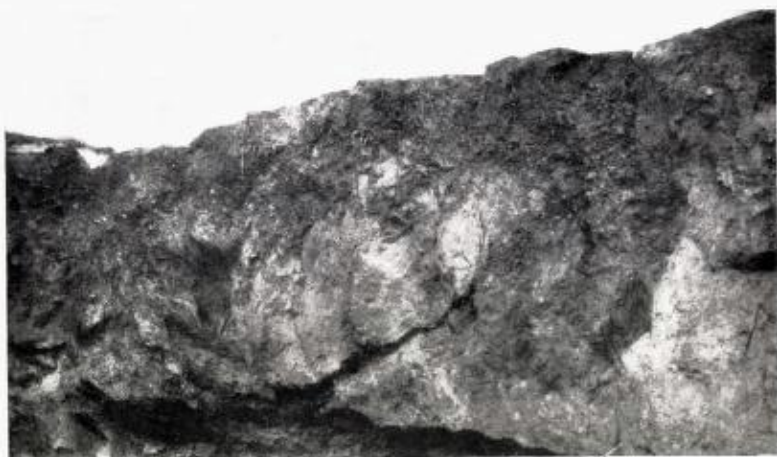
Fig. 13. Trana Teglverks lertak i raset lere (pr. Stenkjær).
