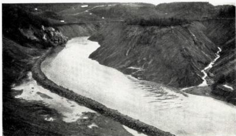
Fig. 12. -Canjon-dannelse i leravleiringene ved Volden i Vårdalen. (Merk forbygningen fra det faste fjeld tilvenstre).
