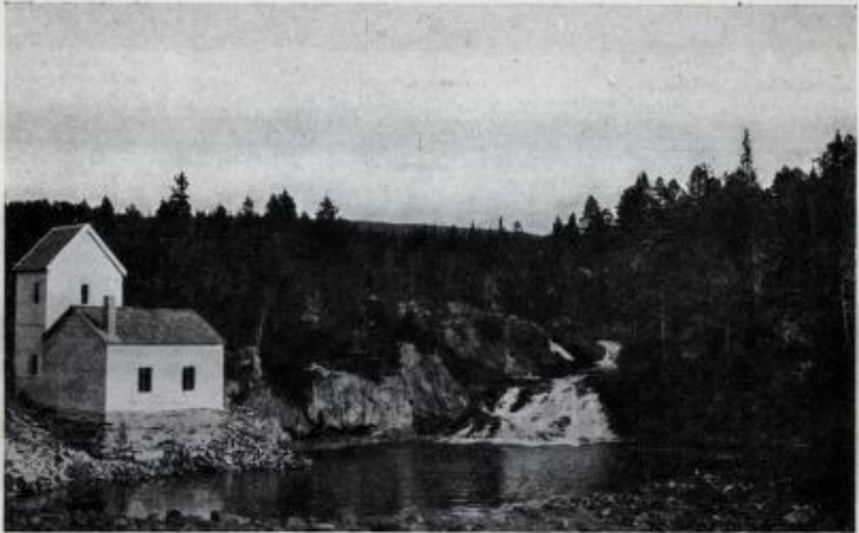
Fig. 22. Killingdal grubes nye kraftstasjon.
