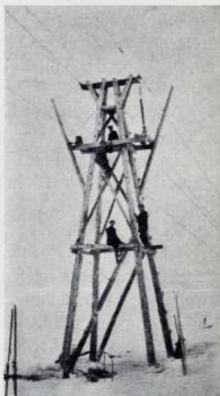
Fig. 37. Kjøli. Taugbanebukk med nedre avstivning for snetrykk.
