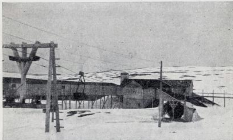
Fig. 19. Killingdals grube. Knuseri og taugbanestasjon.
