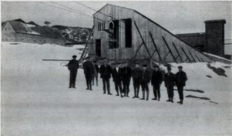
Fig. 36. Ny taugbanestasjon ved Kjølø 1923.
