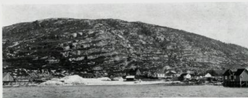
Fig. 3. Hundholmen feltspatbrudd. Flat benkning i granitten. St. Foslie \frac{7}{8} 1929.
