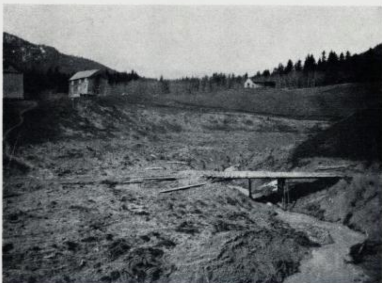
Fig. 3. Leirfallet ved Holund i Grong 1942. I forgrunnen broen 44,40. Foto i retning N 20° V. Mai 1943. Per Holmsen.
