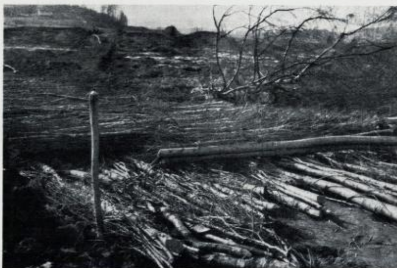
Fig. 2. Faskinunderlaget for den provisoriske vei gjennom rasgropen.
