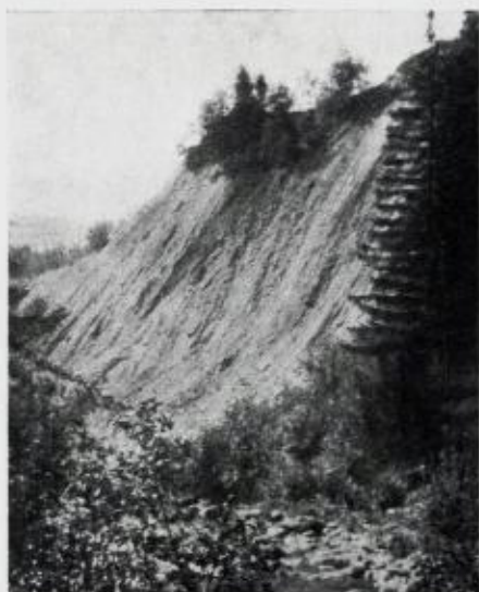
Fig. 30. Skjæring i bregrus rikt på finmateriale på vestsiden av Lange-dalsbekken ved Solbjørg (58.3, 6).
