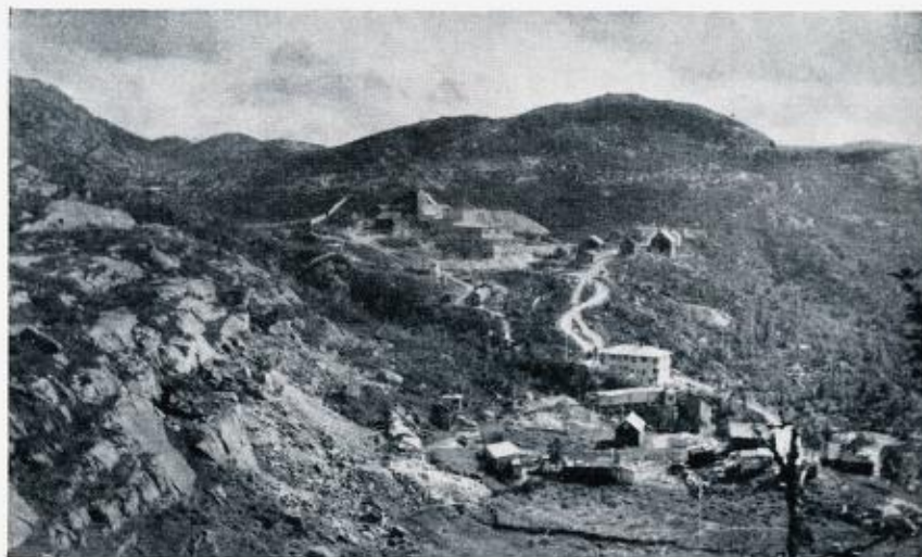
Fig. 6. Utsikt mot syd fra Benkeheiknuten. I bakgrunnen danner de ca. 30^\circ østfallende skifrihetsflater smådalenes vestside. I forgrunnen til venstre danner steilere slepper med vestlig fall bratte avhell ved Benkehei grube. Midt på fotoet vaskeribygningen ved Knaben. Dagbruddet i gangfjellinsen litt ovenfor til venstre.
