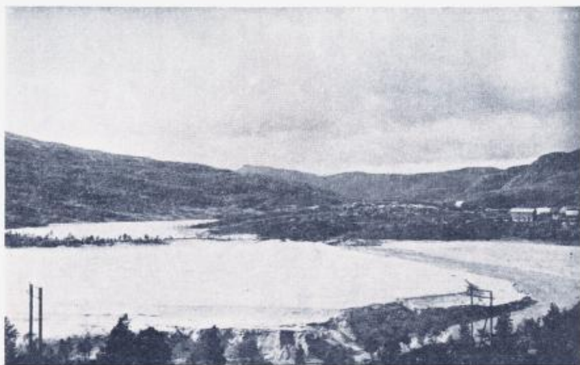
Fig. 5a. I forgrunnen slamhaugen fra vaskeriet. I bakgrunnen og til høyre (5b) den nederste del av «grubebyen» ved Knaben II Grube. Til venstre (a) (i dalens vestsida) ser man terrengets utforming langs de svakt østfallende skifrihetsflater. Til høyre (b) (i dalens østside) ser man steilere avhell langs de vestfallende slepper.
