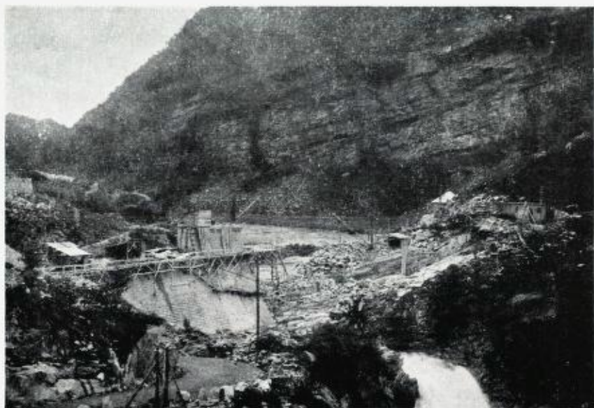
Fig. 4. Dammen ved Storefossen under bygning.
