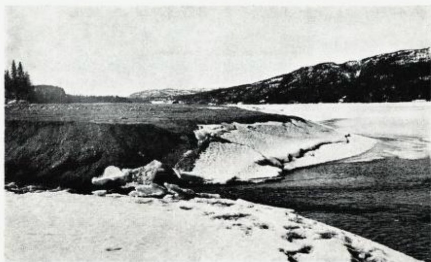
Fig. 11. Grungstadvatnets senkning jan. 1932 som følge av erosjon i utløpet. Lowering of Grungstadvatnet Jan. 1932 due to erosion at outlet.
