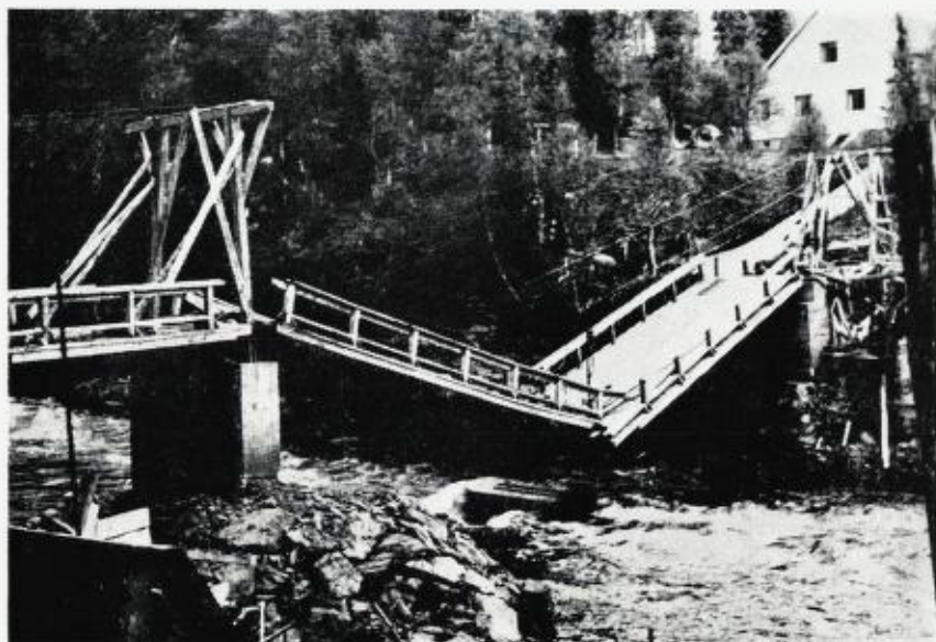
Fig. 9. Broen over Røyrvikelven ødelagt av vårflommen 1954. Bridge over Røyrvikelven, ruined by flooding in the spring of 1954.
