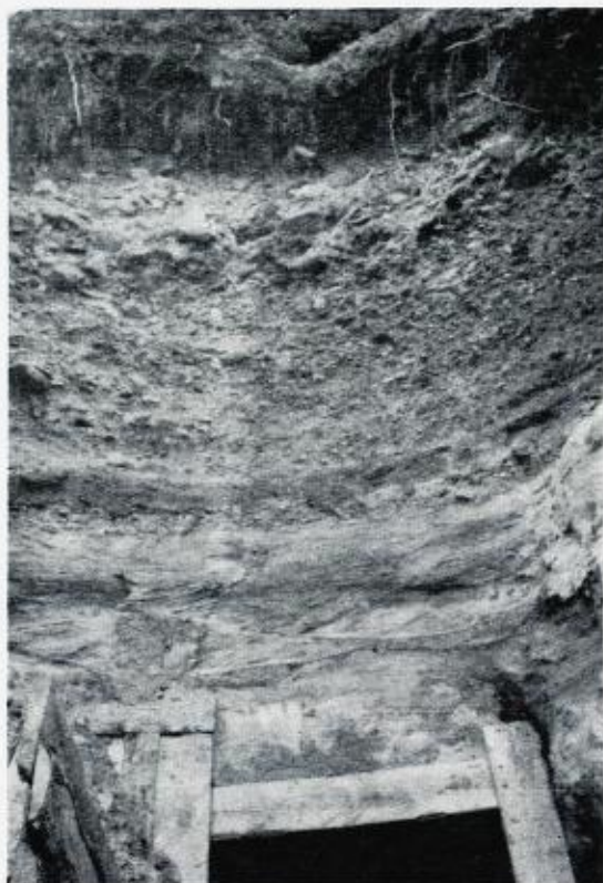
Fig. 16. Forbygget sjakt til fast fjell under sand og morenemateriale (fot. H. Bj.).
