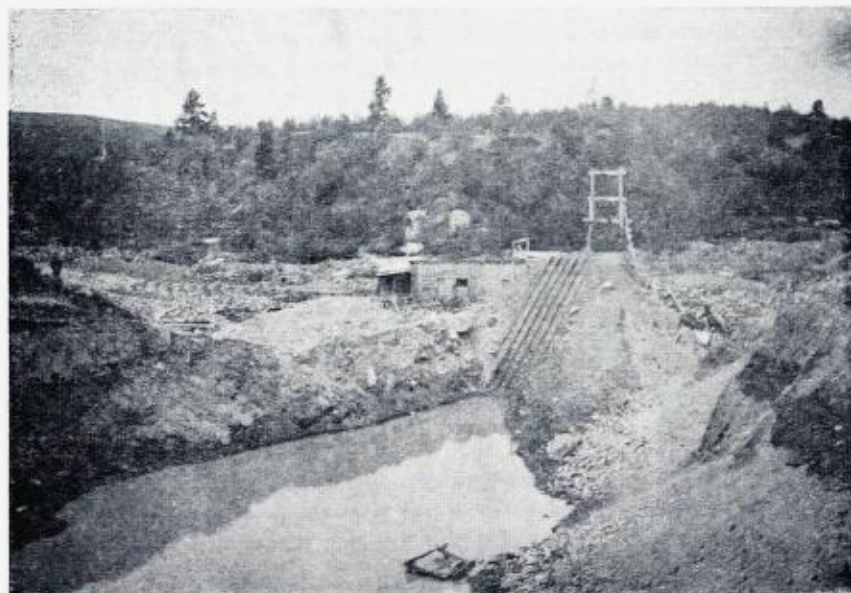
Fig. 17. Fra Sargejok gullfelt. I forgrunnen den sydlige morenebanke som ble utgravet ved en skrapeanordning (fot. H. Bj.).
