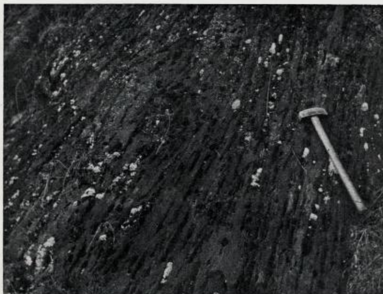
Hullet forvittringsflade i graa fyllit ved Graaberget, syd for Domaas.
