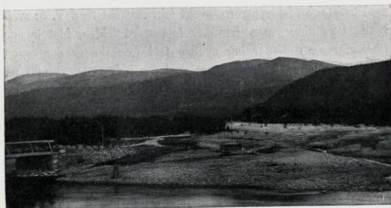
Jettafjeld og Ilka's udløb, seet S. til SSV-over fra Talleraasbroen.
