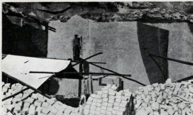
Gatestenshugning i brudd ved Iddefjorden.
