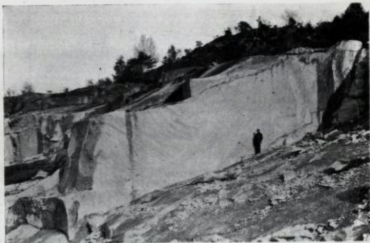
Fra N. S. Beers brudd ved Hov. Den vældige granitklippe er en eneste sammenhengende blok. Den er løssprængt fra fjeldet.
