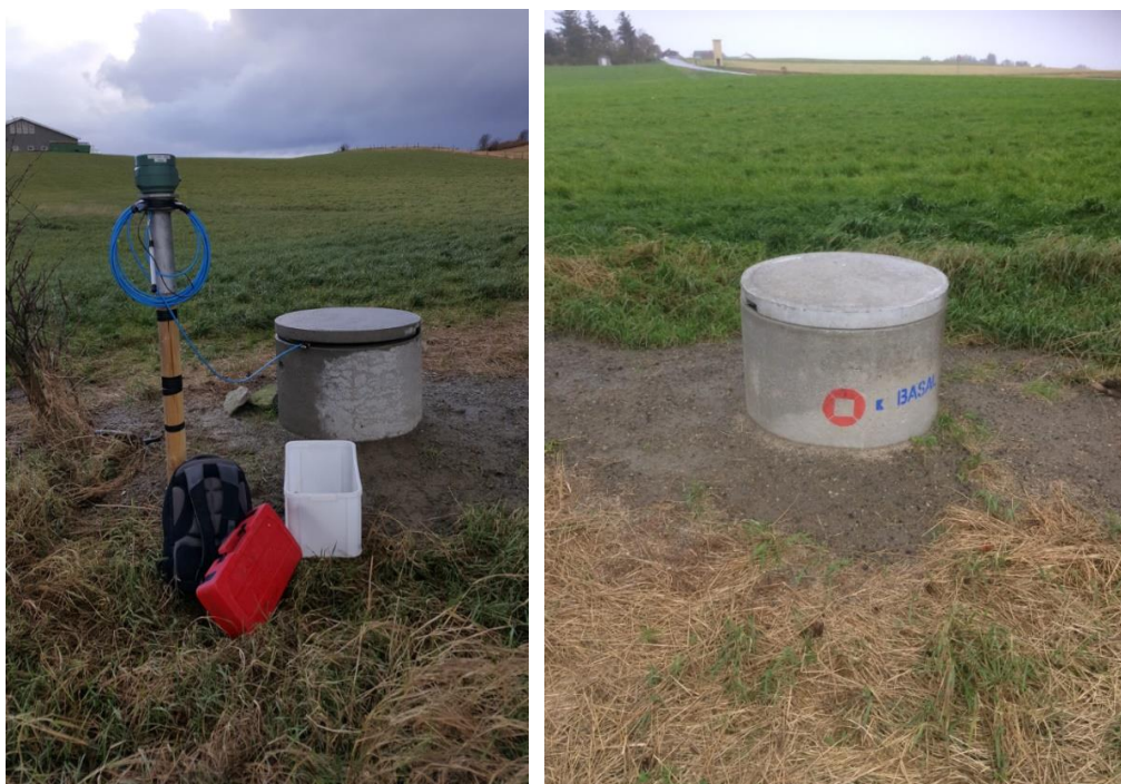
Figur 51: Overvåkingsbrønnen på Horpestad.
