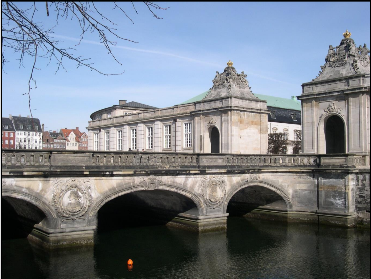
Figur 24. Marmorbroen i København er i stor grad bygget av marmor fra Sunnhordland.
