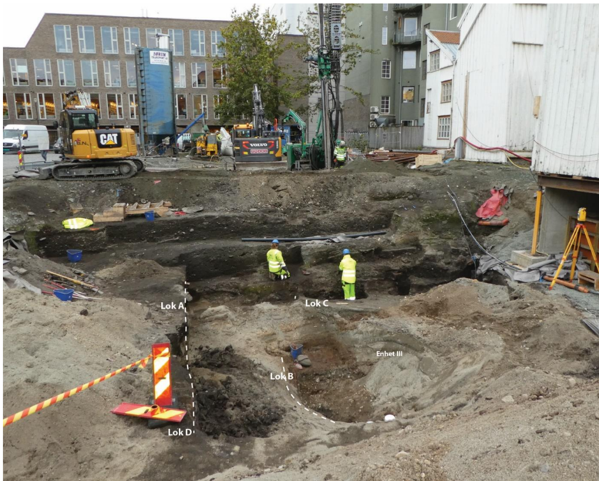
Figur 3. Foto av utgravingens dypeste stadium da det var gravd litt ned i sand- og gruslag (gullige) under de tykke arkeologiske lagene (mørk brune). Merk mindre utrasning langs venstre kant umiddelbart til høyre for oransjestrøpet avmerkningspel. Fotoet er tatt mot sør. Omtrentlig plassering av de undersøkte geologiske lokaliteter samt profilinje mellom lokalitet D og A er markert. Lokalitet B's utstrekning er også vist med stiplet linje. Noe lagdeling er synlig (enhet III, se tekst).
