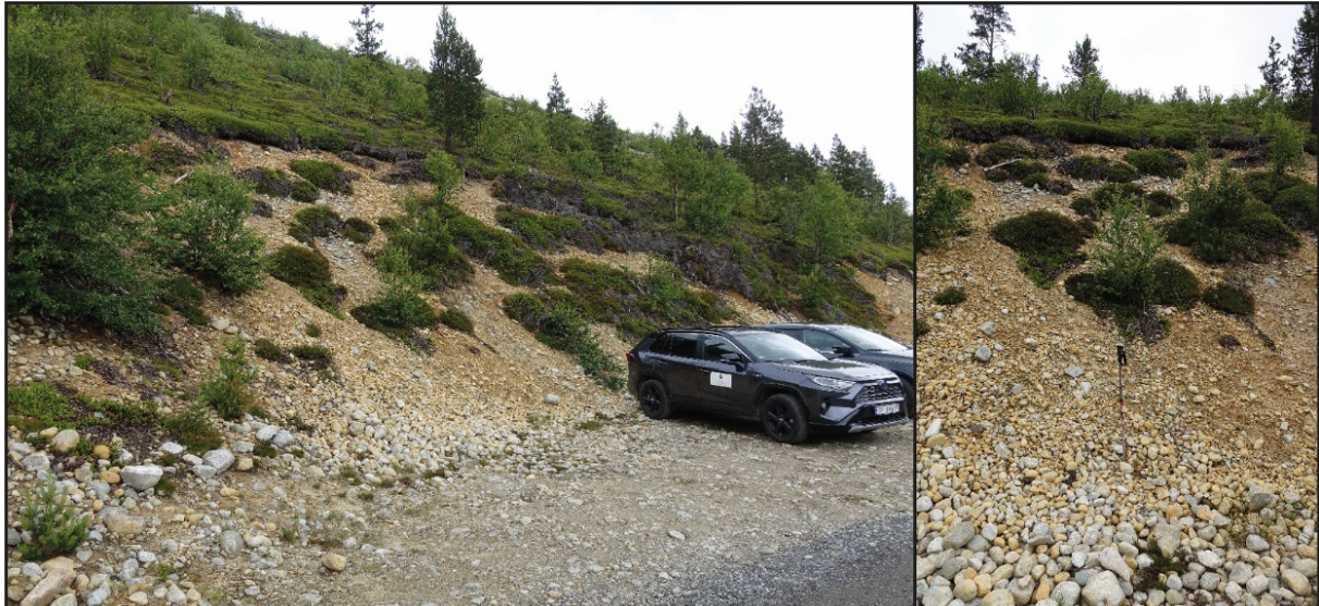
Figur 8: Bilder av massetak 3, som er nå parkeringsplass ved bom. Materialet i denne massetak er grovere enn i massetak 1 og 2 og godt rundete steiner samles opp ved bunnen av stoffen, som er 3 m høy.
