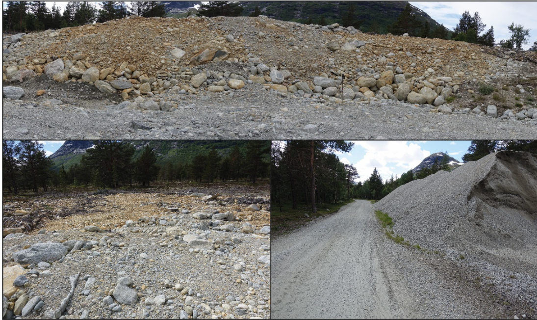
Figur 6: Bilder fra massetak 2. Materialet i det sørlige massetak er enda mer grovkornete enn i massetak 1. Trær og delvis jordbunnen har blitt fjernet i den ytre delen av massetaket (nedre venstre bilde). På den sørlige grensen av massetaket er knuste masser lagret, som sannsynligvis er brukt til vedlikehold av grusveien (nedre høyre bilde og Figur 3).
