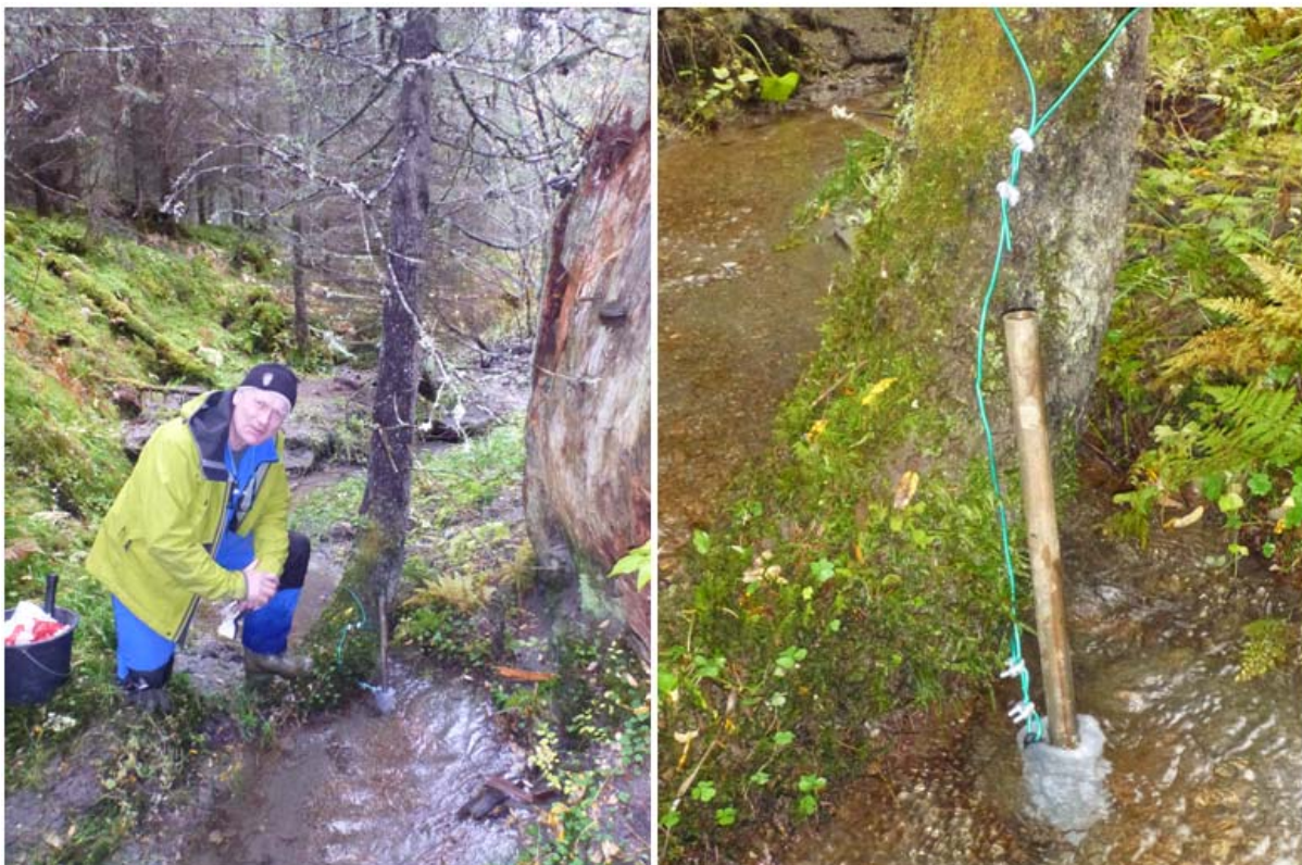
Figur 17: Installasjon av automatisk logger av trykk, temperatur og elektrisk ledningsevne i kildebekken i kildeområdet (bilder: A. Dagestad).
