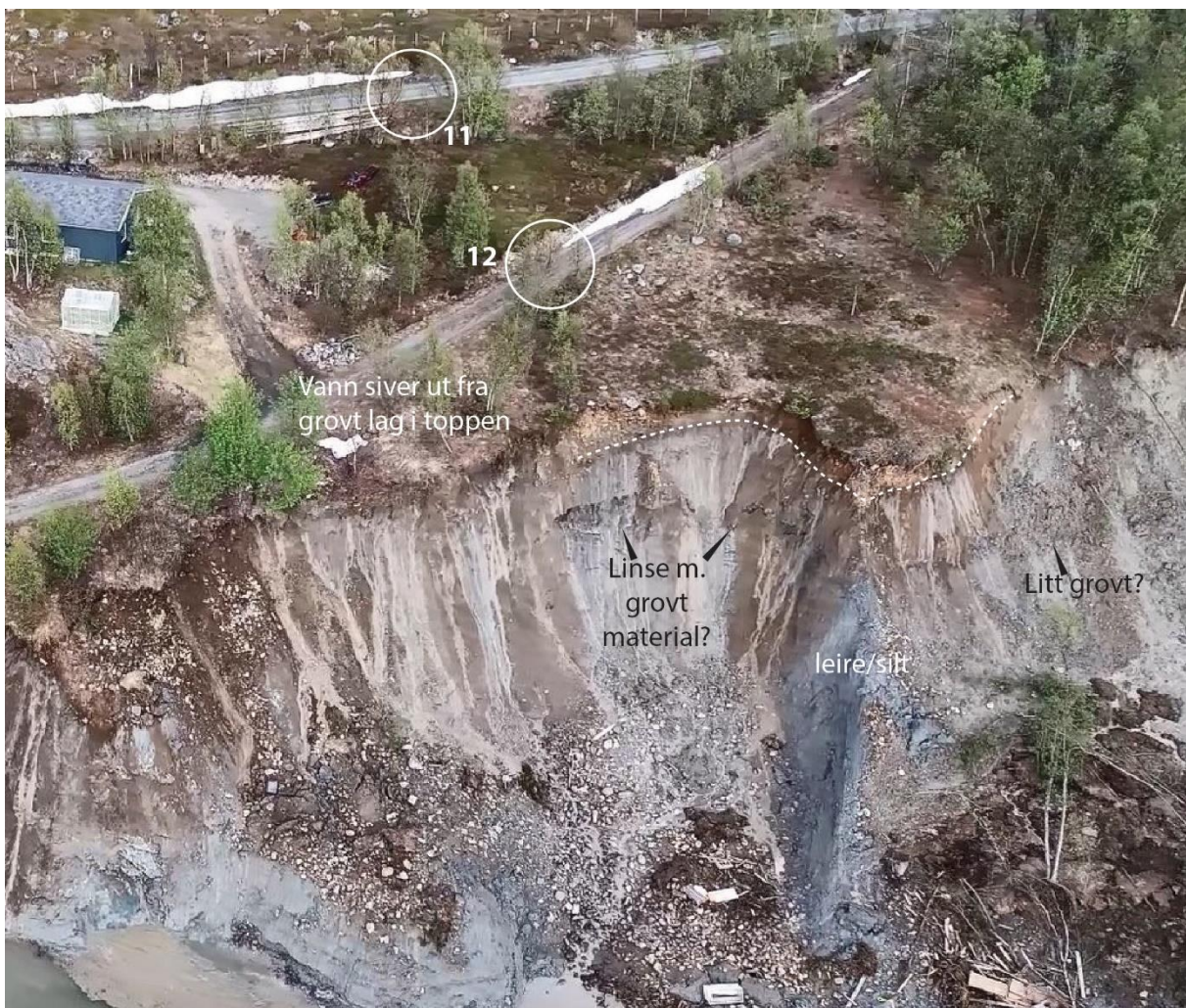
Figur 16. Sektor III samme dag som skredet gikk. Mye finstoff (leire/silt) er eksponert i skredkanten. En linse med tilsynelatende grovere sediment er fremhevet med svarte piler. Linsen synes muligens å fortsette langs skredkanten mot sør (svart pil til høyre i fotoet). Omtrentlig plassering av boring 11 og 12 er markert (Multiconsult 2020; foto: Anders Bjordal, 3. juni).
