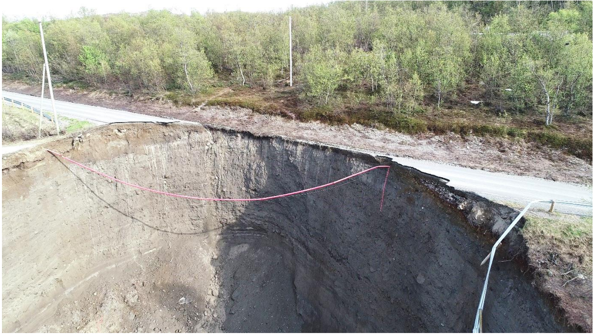
Figur 27. Skredkanten i sektor V kort tid etter at skredet tok gamle E6. Den c. 10 m høye bakkanten er dominert av lagdelt grus, men er muligens mer sandig i den nederste delen (Foto: Anders Bjordal, NVE).
