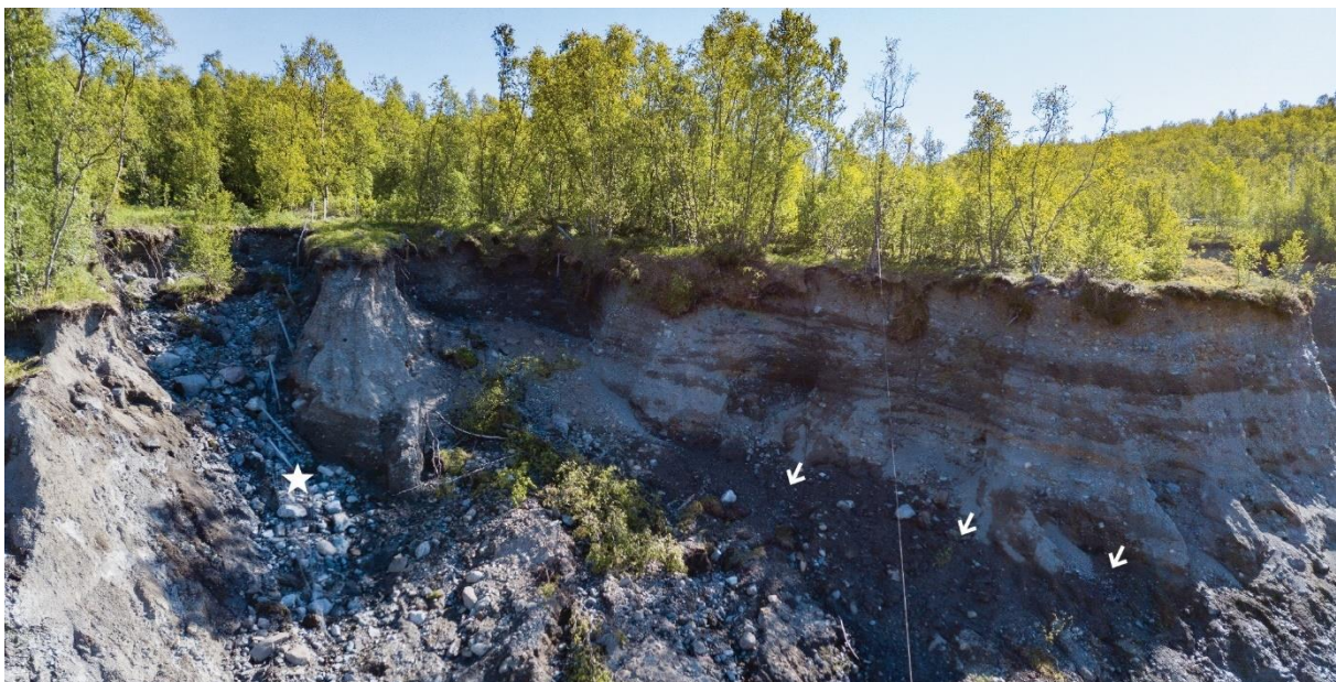
Figur 20. Gruslag som heller i nordvestlig retning i sektor IV. Piler peker på mørk, fuktig grus, i grensen til mer finkornet material under. Hvit stjerne angir plassering av steiner på Fig. 19. Foto: Raymond Eilertsen, 22. juni.
