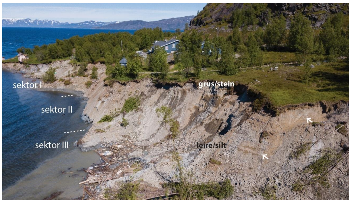
Figur 17. Oversikt over sektor I-III. Merk det lyse relativt finkornede laget (sand/silt?) under litt grus i toppen av skråningen ved øverste pilen til høyre. Mulige sandlag i leire/silt er også vist med nederste pilen. Foto: Raymond Eilertsen, 22. juni.
