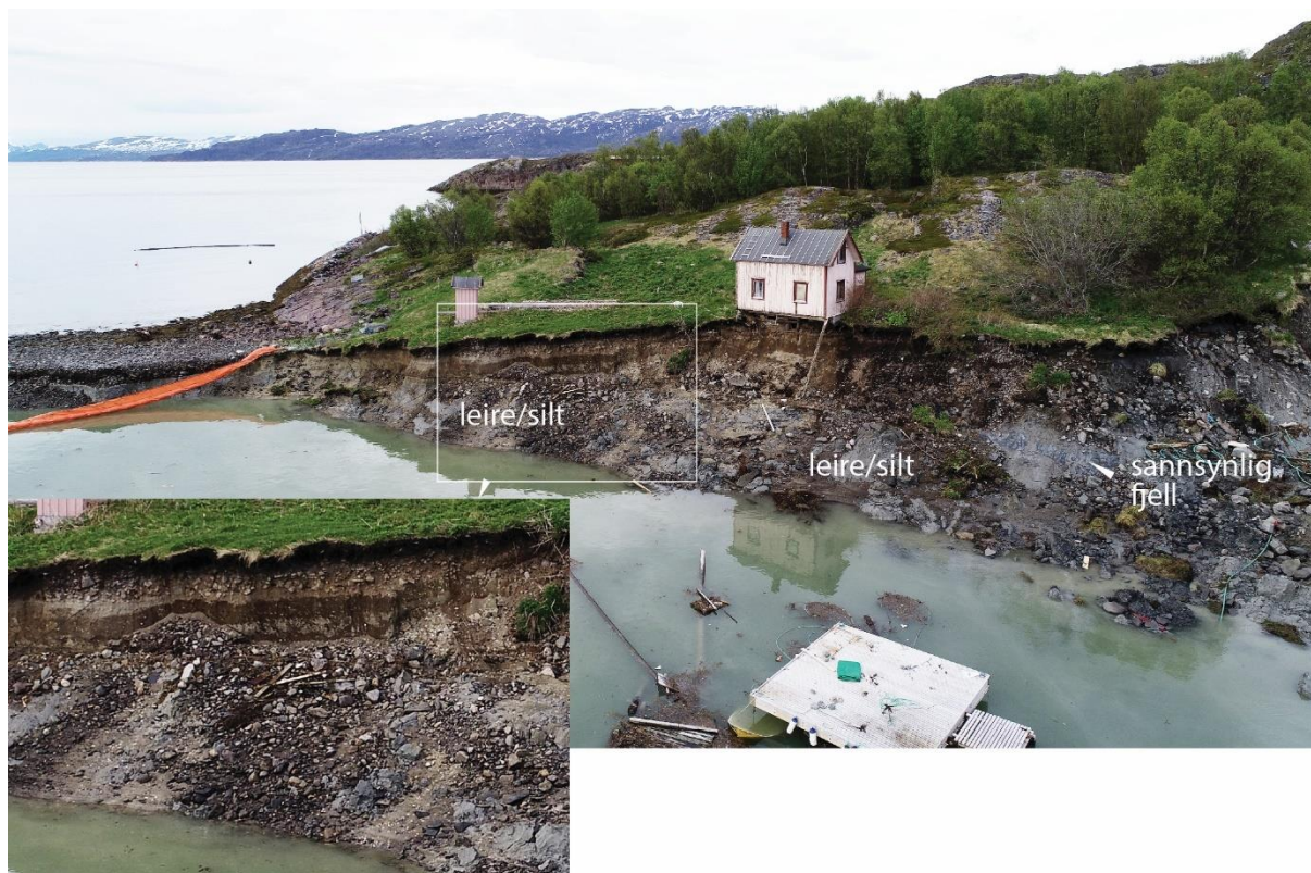
Figur 12. Foto i nordøstlig retning over sektor I (foto: Anders Bjordal, 18. juni). Leire/silt (grålig) sees under grovere, lagdelte masser (strandavsetninger). Det ser ut til å være fjell som blottes til høyre i fotoet.
