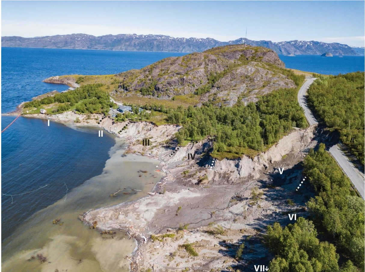
Figur 4. Overblikk mot nordøst over Kråknesskredet ved Flatstrand (foto: Raymond Eilertsen, 22. juni). Romertal angir sektorer av skredets bakkant som beskrives i teksten mht lagfølger, se også Figur 10. Grensene mellom sektorene er markert med stiplet strek.
