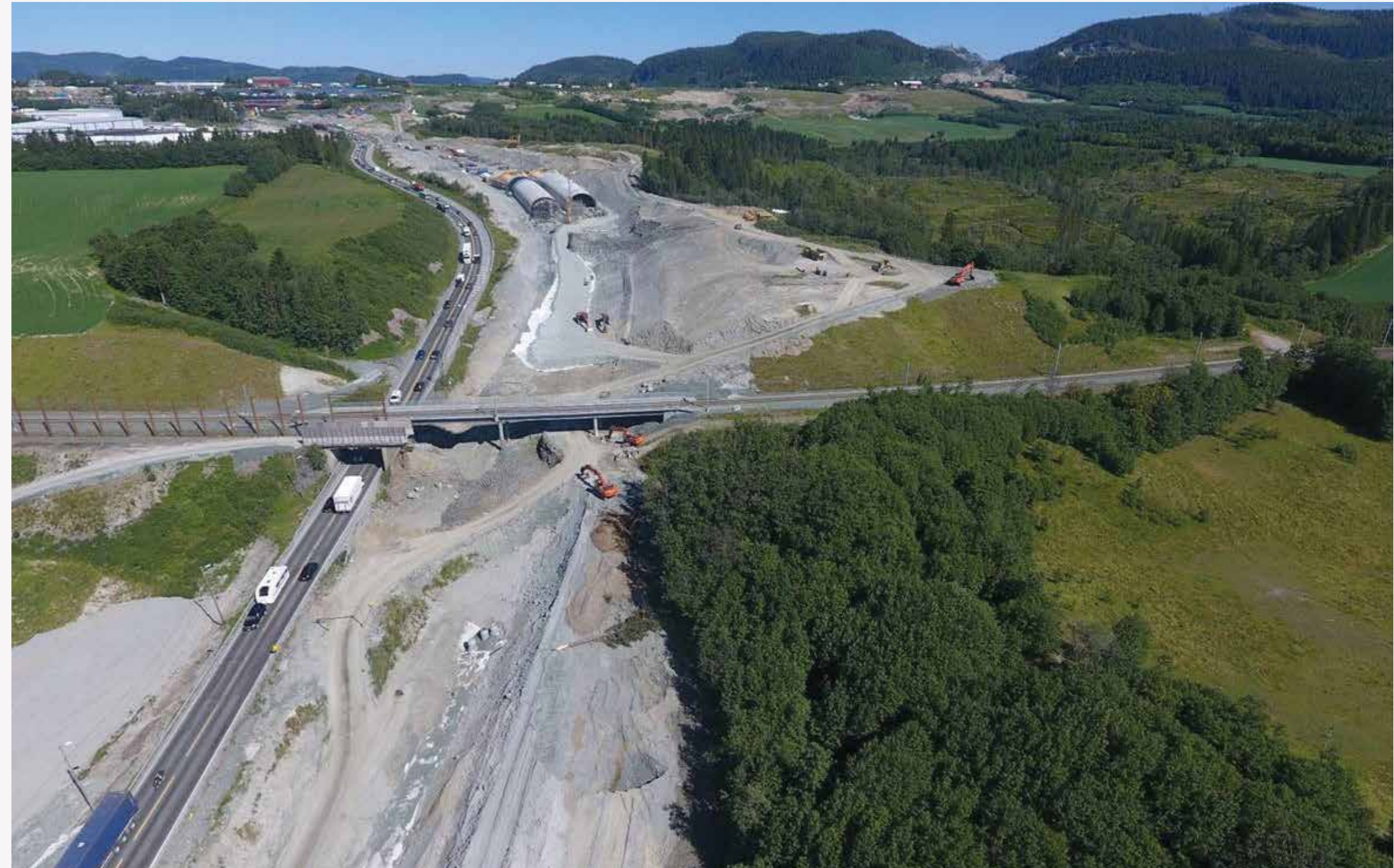
En stor del av lokalt byggeråstoff i Trøndelag i 2018 ble brukt til byggingen av E6 mellom Trondheim og Melhus.
