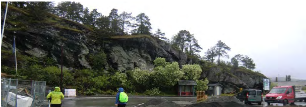
Figur 65: Bergblotningen ved lokalitet ved Storvikaveien.
