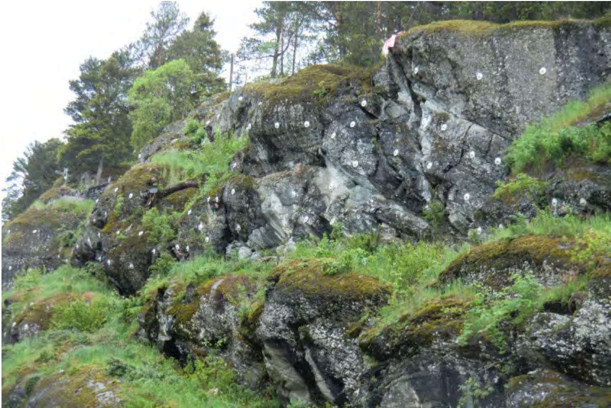
Figur 66: Hva slags sikring er dette?
