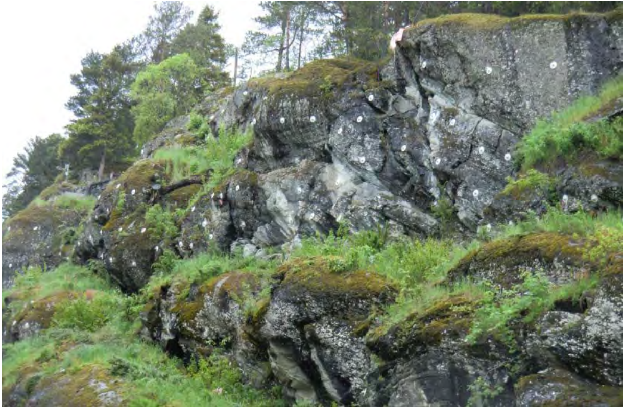
Figur 72: Hva slags sikring er dette?
