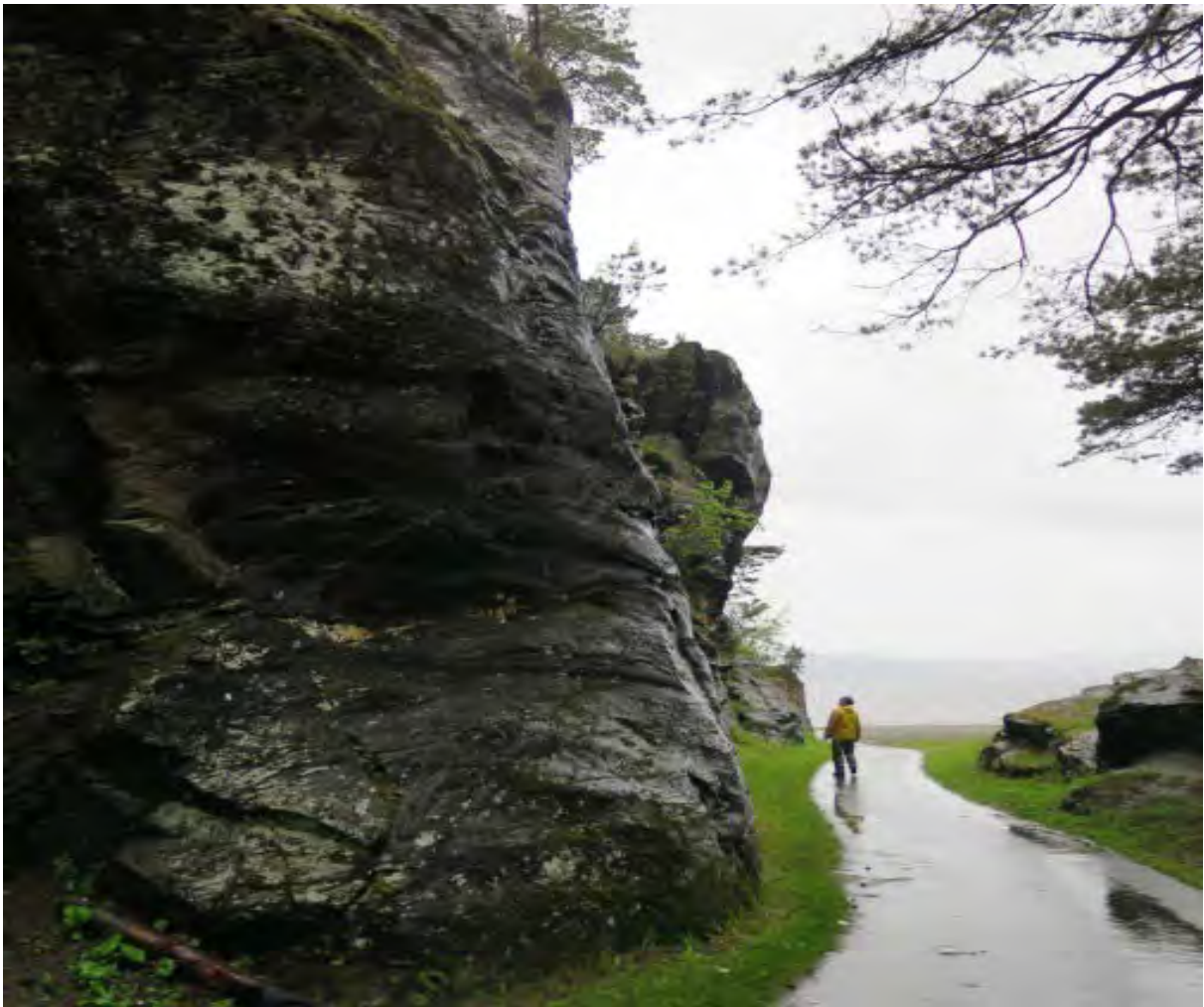
Figur 67: Bildet viser bergblotningen på venstre side som skal studeres nærmere. Bildet er tatt fra parkeringsplassen og ut mot stranden i Storvika.
