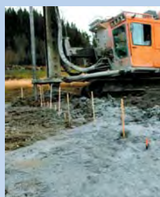
En boremaskin blander sement og kalk inn i kvikkleira. Det gjør den stabil igjen.
