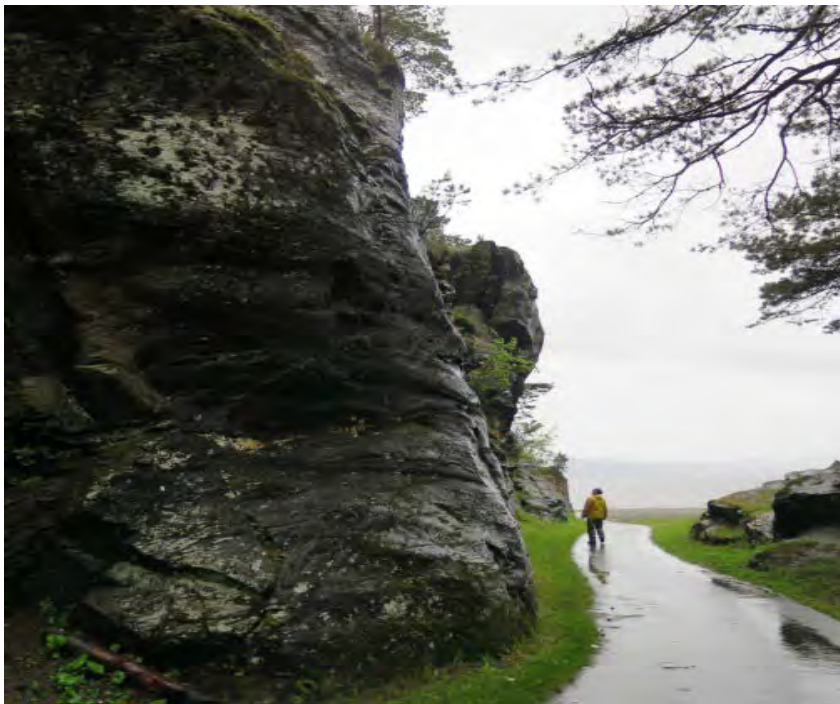
Figur 51: Bildet viser bergblotningen på venstre side som skal studeres nærmere. Bildet er tatt fra parkeringsplassen og ut mot stranden i Storvika.
