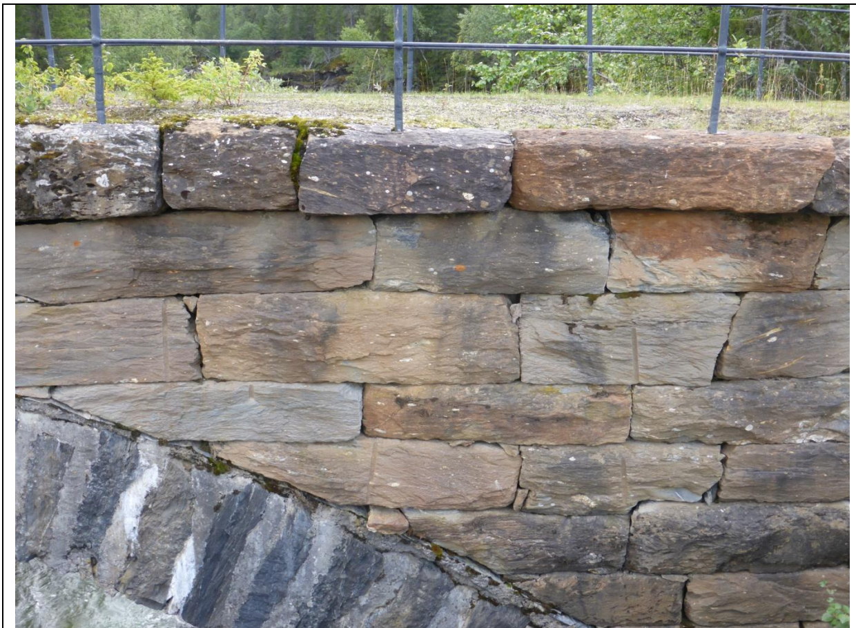
Figur 24: Diamiktitt brukt i brua over Unkerelva.
