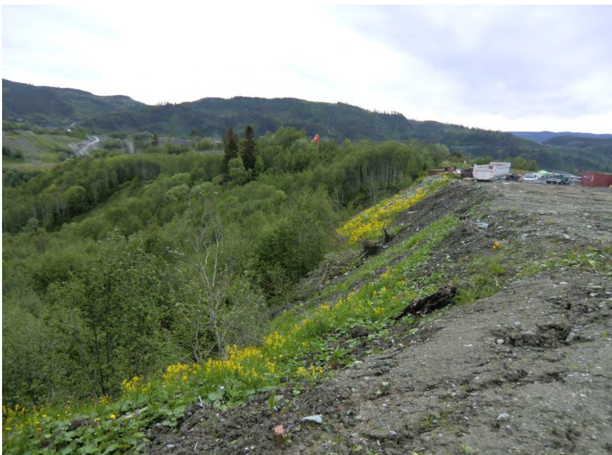
Figur 36: Skredkanten og deler av skredgropa. På andre siden (oppe til venstre i bildet) ser man grusuttaket ved Ekle.
