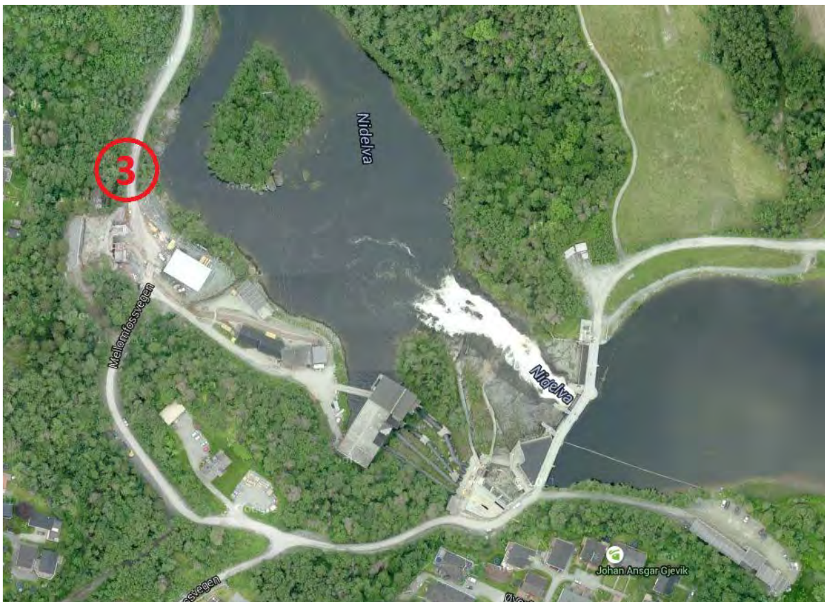
Figur 38: Øvre Leirfoss kraftstasjon.
