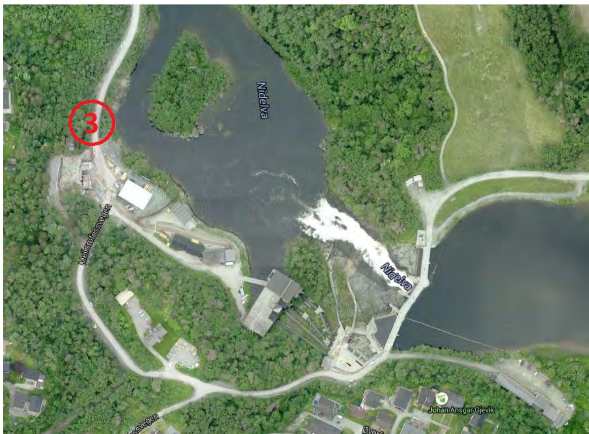
Figur 51: Øvre Leirfoss kraftstasjon.
