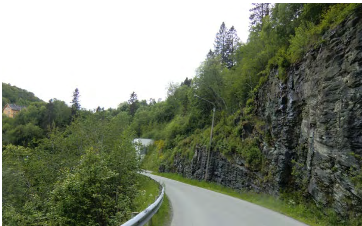
Figur 52: Bergblotningen ved Øvre Leirfoss Kraftstasjon.
