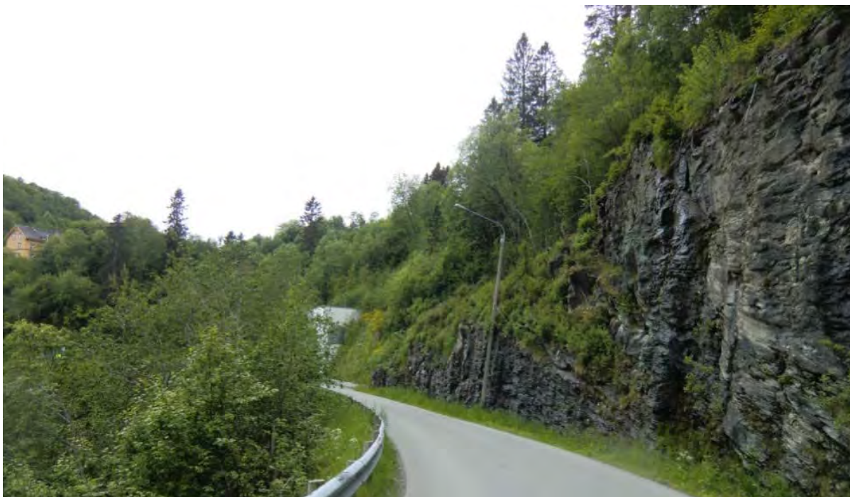
Figur 39: Bergblotningen ved Øvre Leirfoss Kraftstasjon.
